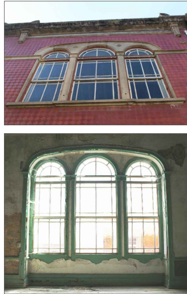
Imagem 216 e 217 - Levantamento fotográfico da Janela V6 - exterior (cima) e interior (baixo)
