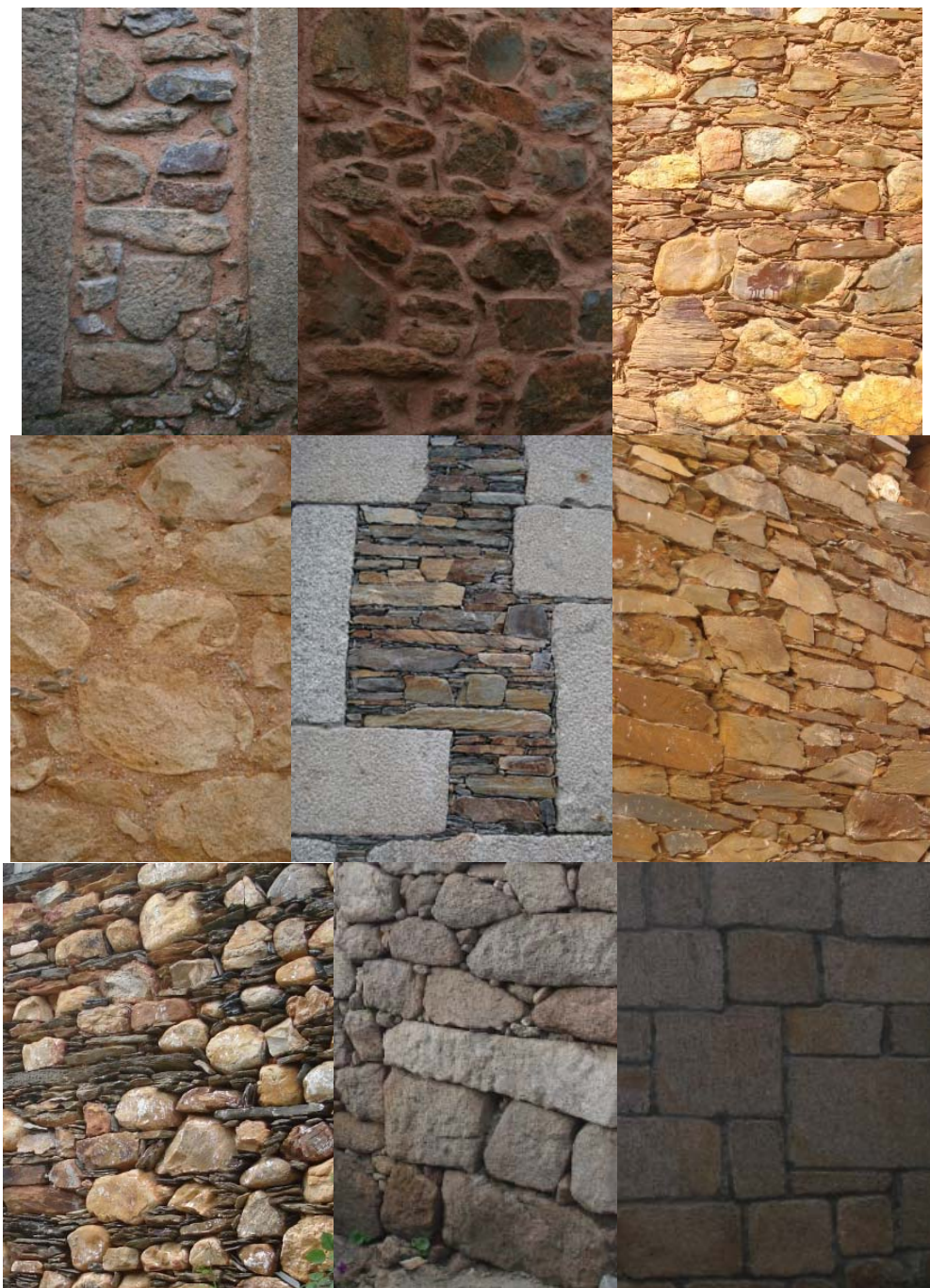
Foto 4.11 – Tipos de alvenarias observadas na região OCREubi
