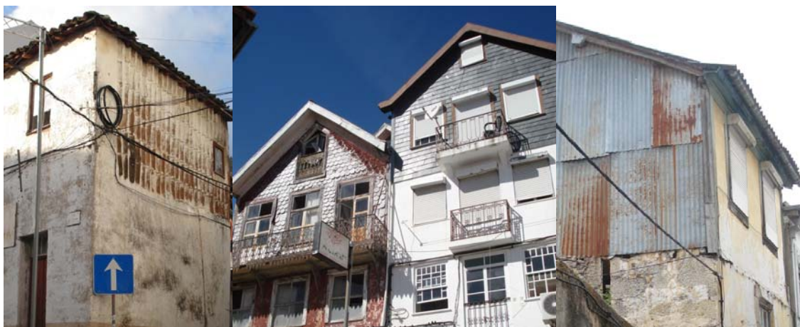
Foto 4.16 – Tipos de protecção do tabique
