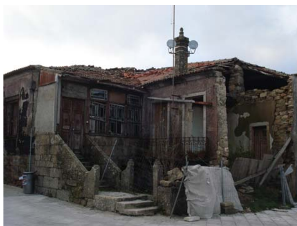
Foto 4.3 - Casa típica com varanda envidraçada e escada exterior (🏠)
