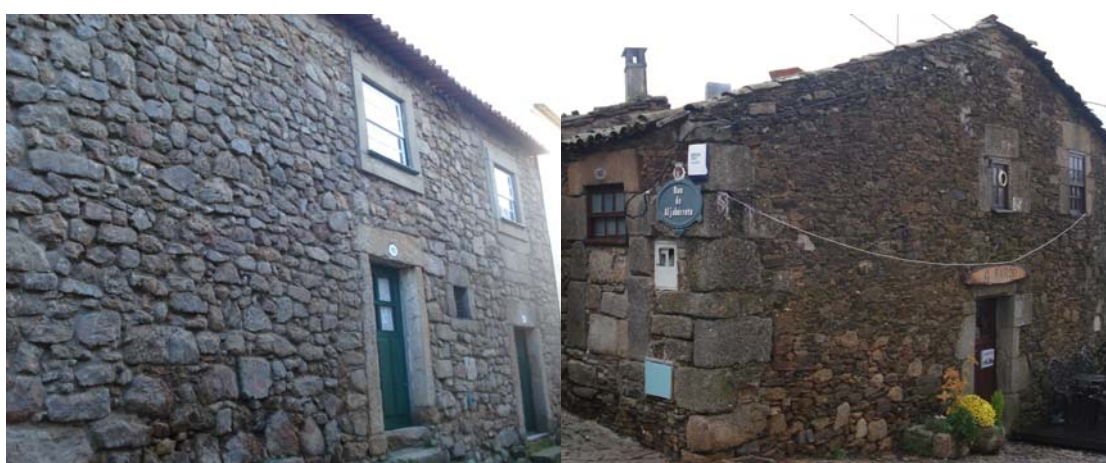
Foto 4.13 - Alvenaria de pedra ordinária
