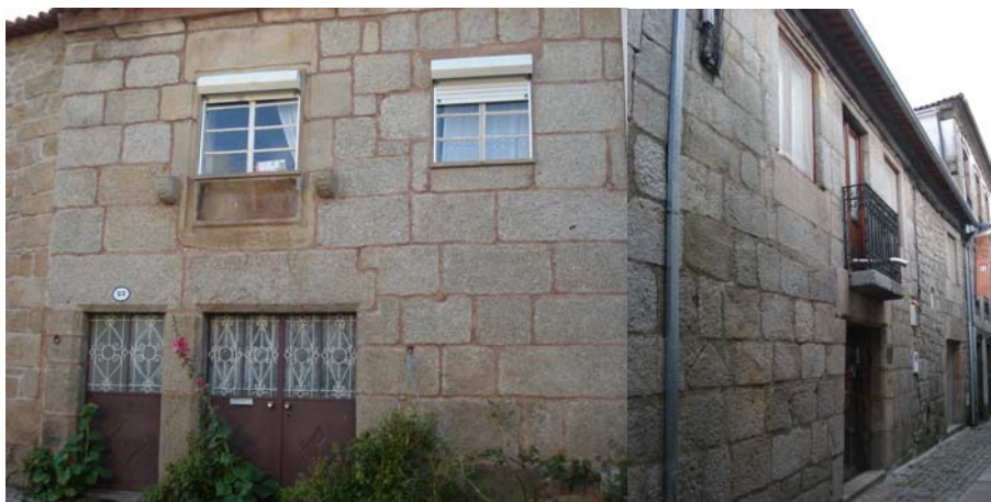
Foto 4.12 - Alvenaria de pedra aparelhada
