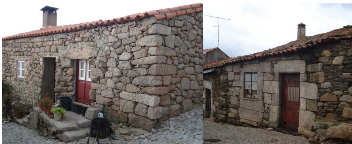
Foto 4.14 - Alvenaria de pedra seca
