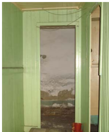
Foto 4.17 – Tipo de paredes interiores de madeira
