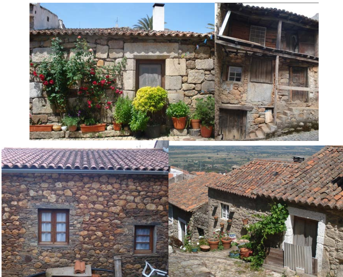
Foto 4.18 – Coberturas típicas de telha de canudo na região OCREubi
