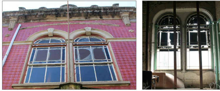
Imagem 225 e 226 - Levantamento fotográfico da Janela V7 - exterior (esquerda) e interior (direita)
