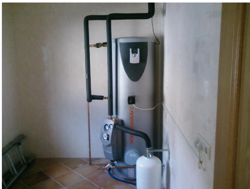
Figura 49 – Sistema Solar Térmico – Circulação forçada.
