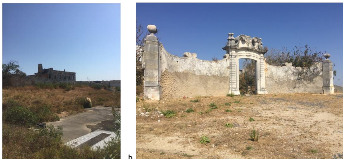
0.4. Ruínas do Palácio da Quinta dos Alfinetes: a. vista do lado noroeste do terreno da proposta; c. entrada do antigo palácio.
