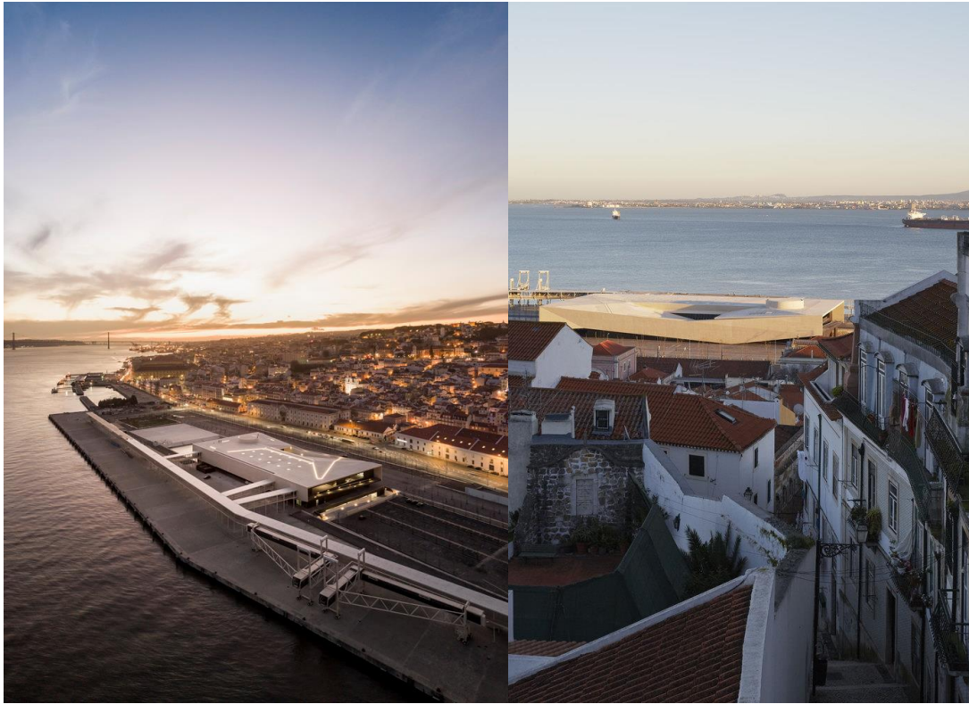
Figura 23 - Vista geral do Terminal de Cruzeiros
