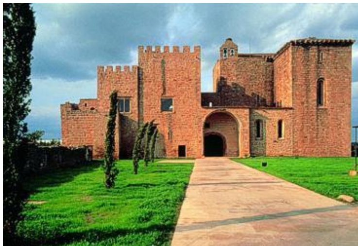
Figura 14 - Fachada Principal da Pousada
