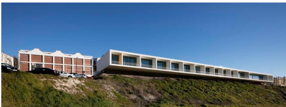
Figura 7 - Fachada Sul da EHTP
