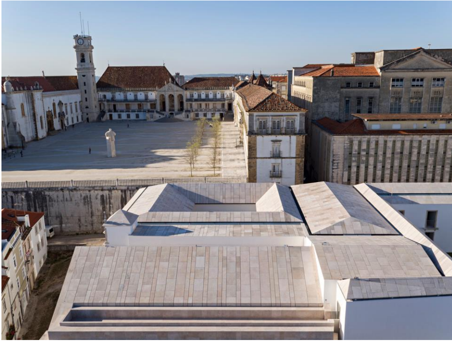
Figura 12 - Vista geral da cobertura
