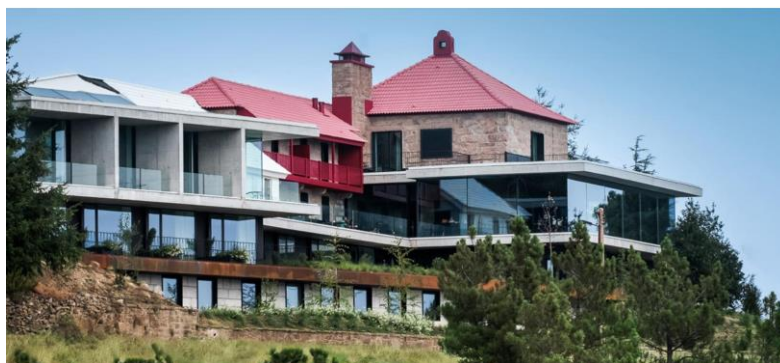
Figura 21 - Vista geral da Pousada a Sul
