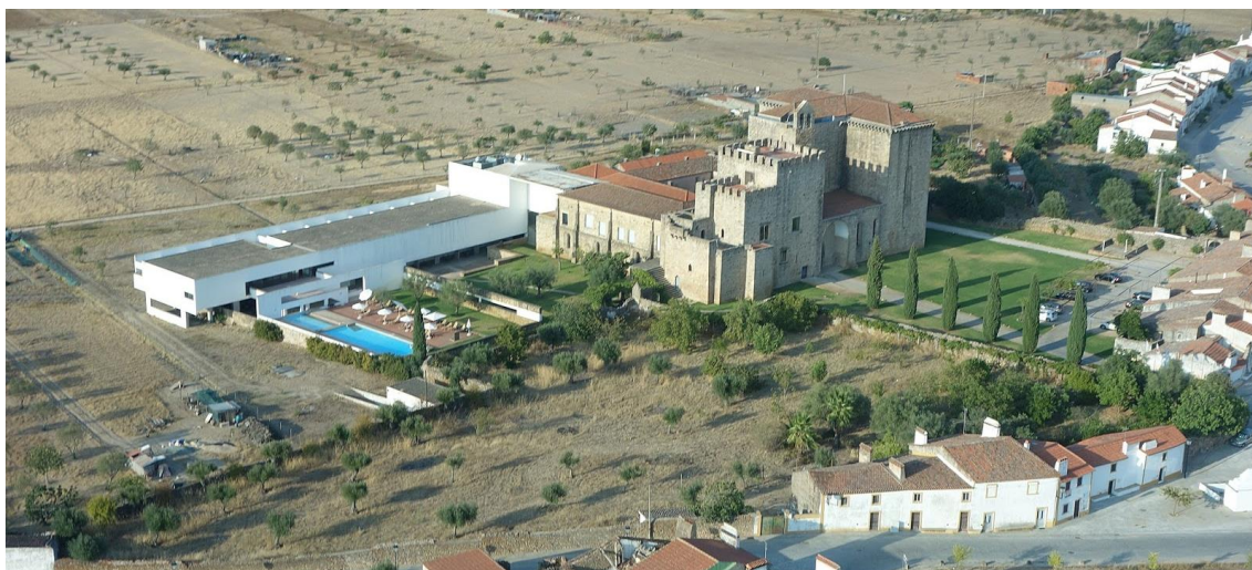
Figura 13 - Vista geral da Pousada Flor da Rosa, Crato
