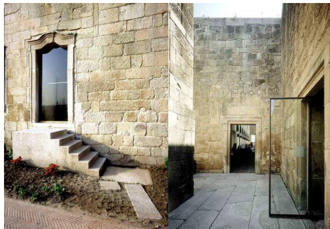
Figura 4 - Portas e janelas com uma caixilharia impercetível
