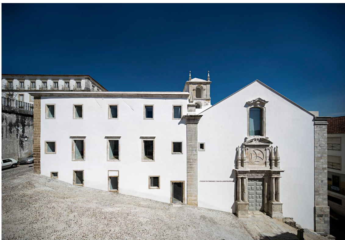
Figura 9 - Fachada Principal do Colégio da Trindade, Coimbra
