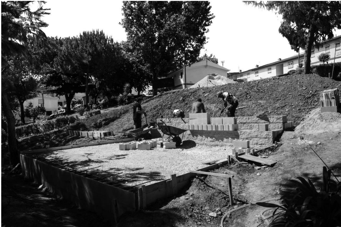
Figura 32 - Construção do anfiteatro no Bairro Prodac - registo fotográfico durante a construção
