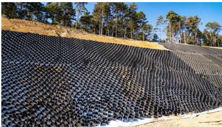
Figura 2.2-Talude estabilizado com geossintéticos
