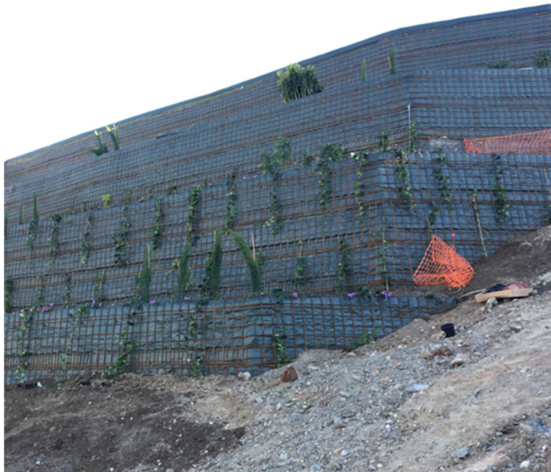
Figura 4.3-Vista parcial do muro concluído com aplicação da vegetação
