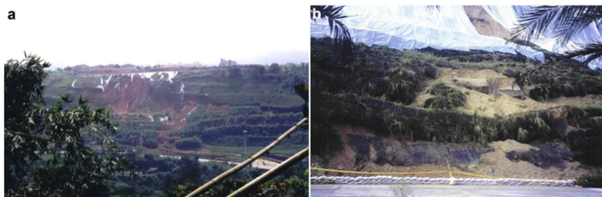
Figura 3.4-Falha do talude reforçado na Secção A-A devido ao sismo de Chi-Chi em 1999:
