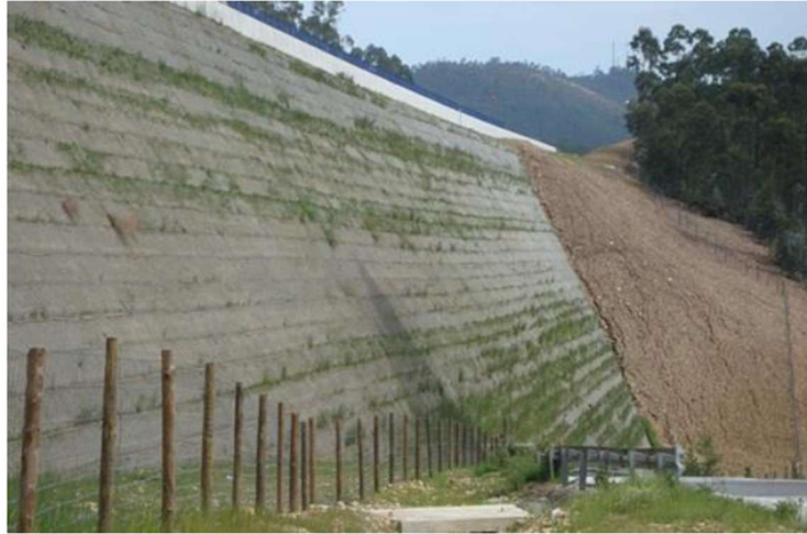
Figura 3.6-Fotografia do local do aterro da autoestrada A32 (Vieria, 2014)
