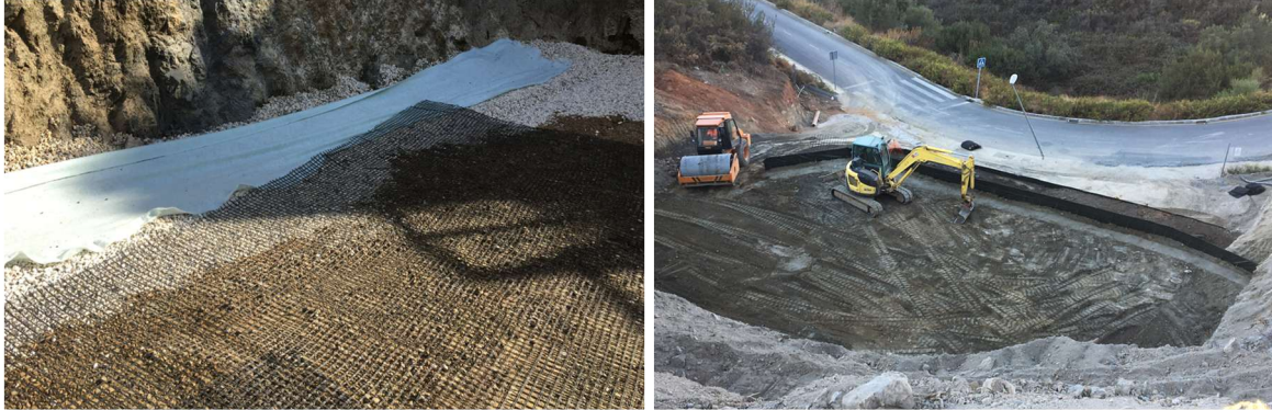
Figura 4.5-a) Camada de drenagem e disposição horizontal das geogrelhas; b) Vista da execução de uma camada do muro verde
