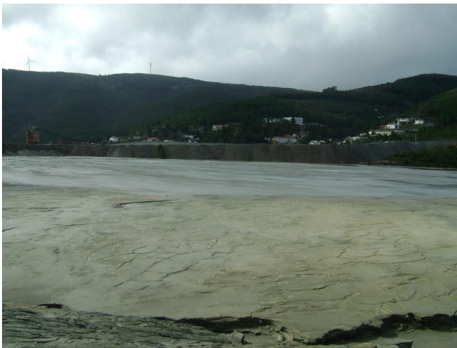
Figura 4.1 - Barragem nº 2 de depósito das lamas das Minas da Panasqueira.
