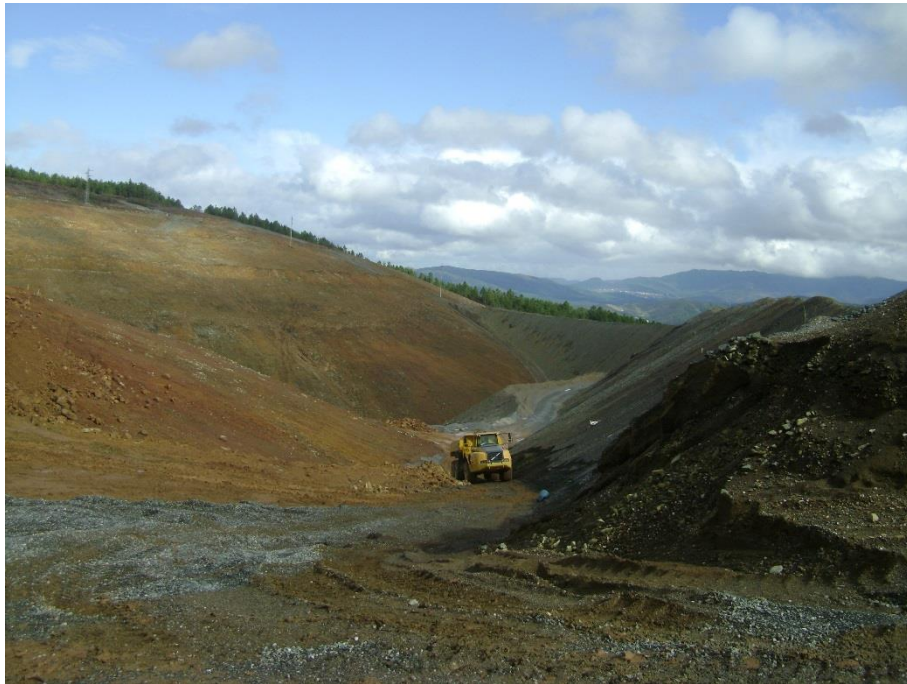
Figura 4.2 - Barragem nº 3 ainda em fase de construção.
