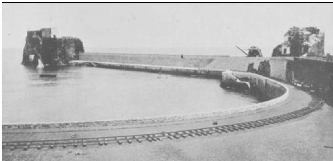
Fig. 39: Porto do Funchal durante as obras de construção do molhe, c. 1890.
