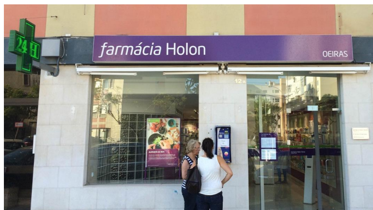
Figura 2 - Fachada exterior da Farmácia Holon Oeiras.
