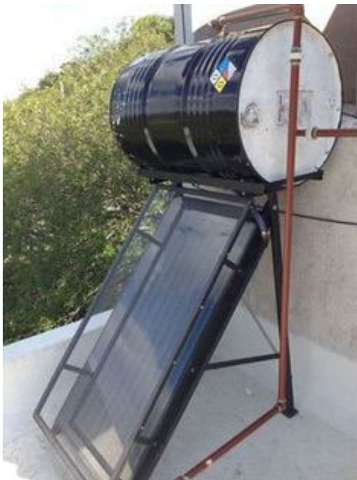
Figura 39: Sistema autoconstrução para reaproveitamento de energia solar térmica. Fonte: Pinterest - https://www.pinterest.pt/pin/680676931198464734/
