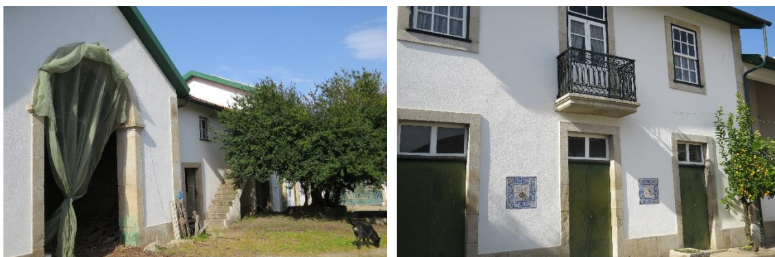
Figura 46 - Espaço de arrumo e casas destinadas aos caseiros e outros subordinados da Quinta.
