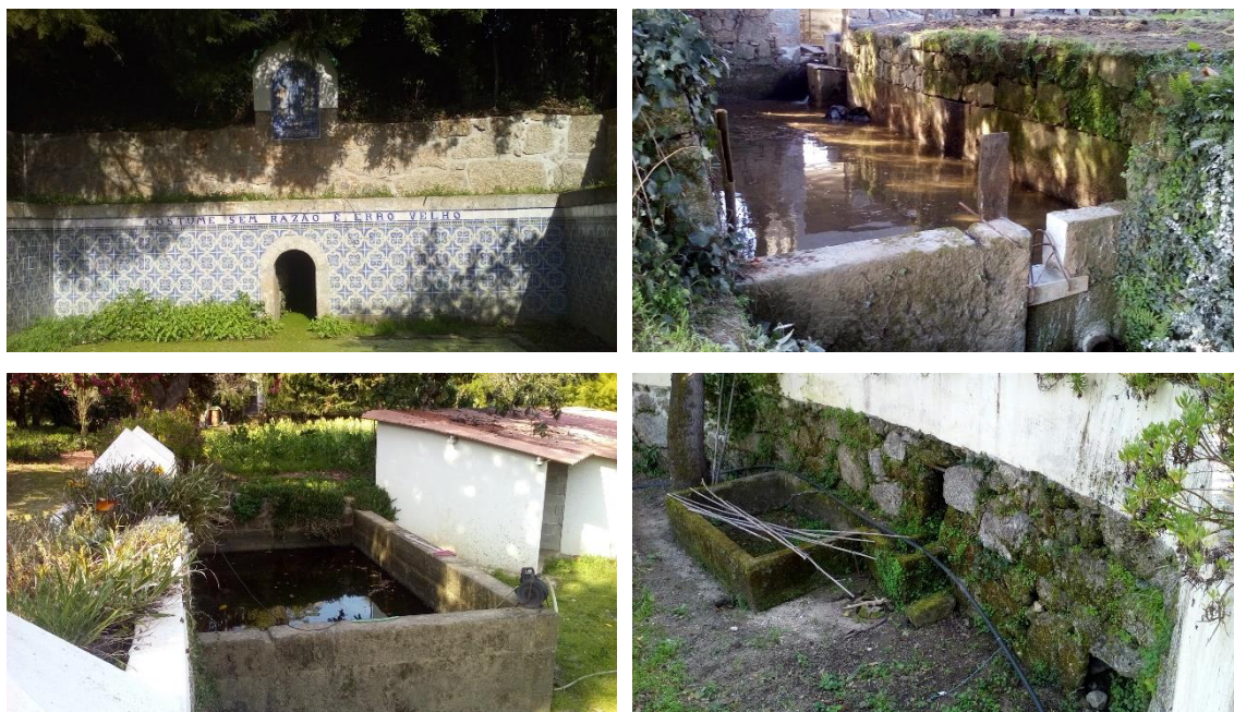
Figura 57 - Tanques existentes na zona de hortas, destinados à rega e à ornamentação desta.
