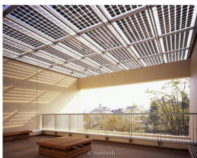
Figura 3.2 - Telhado de vidro com módulos BIPV transparentes [52]
