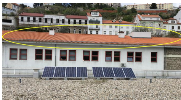
Figura 6.5 - Local de instalação das telhas solares. Fonte: Próprio autor
