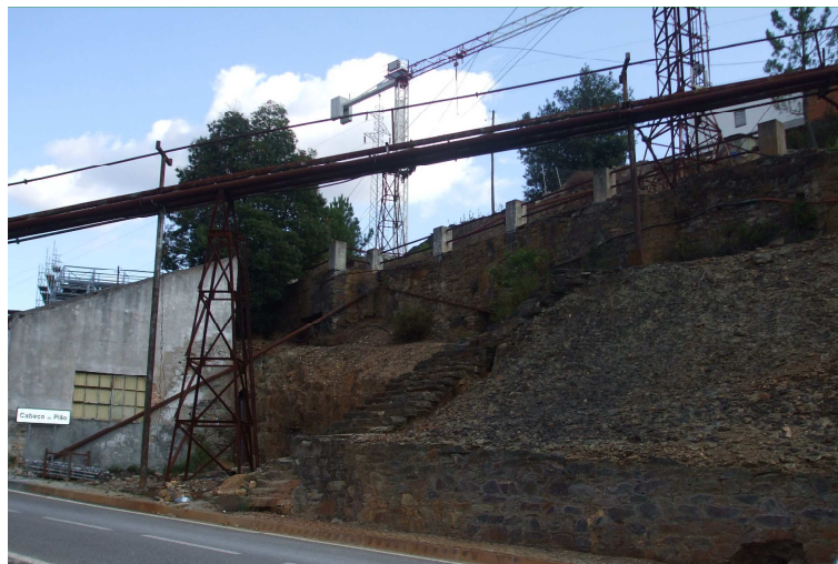
Figura 3.3: Muros elaborados com Resíduos das Minas da Panasqueira
