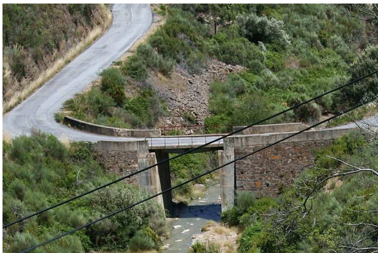
Figura 3.4: Ponte elaborada com Resíduos das Minas da Panasqueira
