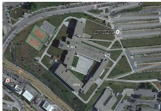
Figura 6 - Vista aérea da Faculdade de Ciências da Saúde (FCS) e localização da ETA 4 (Fonte: GoogleMaps)
