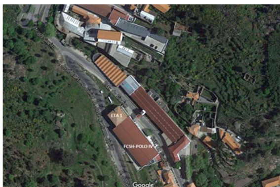
Figura 3 - Vista aérea da Faculdade de Ciências Sociais e Humanas (FCSH) e localização da ETA 1 (Fonte: GoogleMaps)
