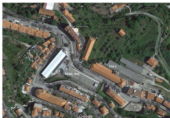
Figura 4 - Vista aérea da Residência Pedro Álvares Cabral (PAC) e localização da ETA 2 (Fonte: GoogleMaps)
