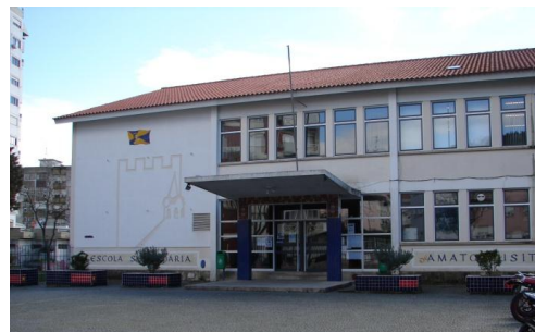
Figura I.13. - Entrada Principal da Escola (3.º piso).
