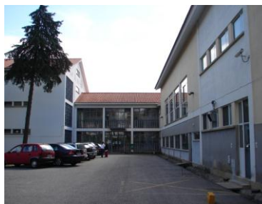
Figura I.15. - Entrada da Escola (2.º piso).
