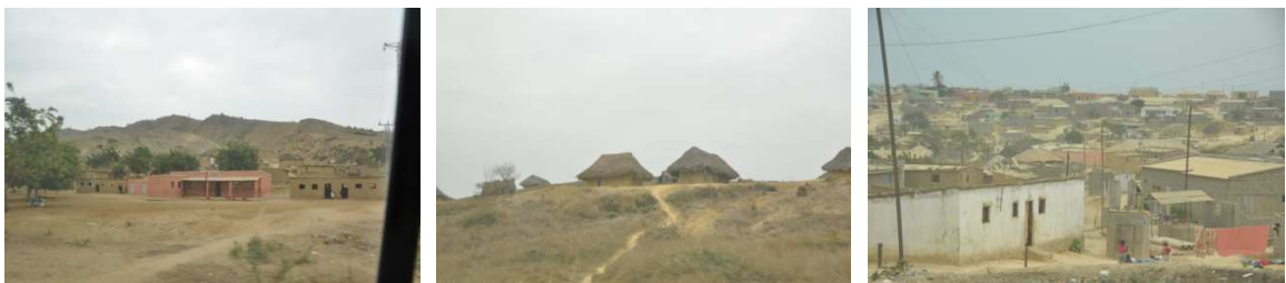
F.02. - Fotografias de habitações unifamiliares em barro e colmo. Estrada colonial Luanda- Benguela, Angola. Julho 2012.
