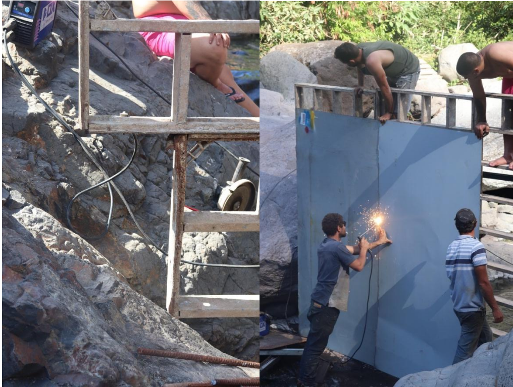
Figura 34. Cofragens apoiadas na rocha; voluntários soldam as chapas à cofragem. - Imagem do autor
