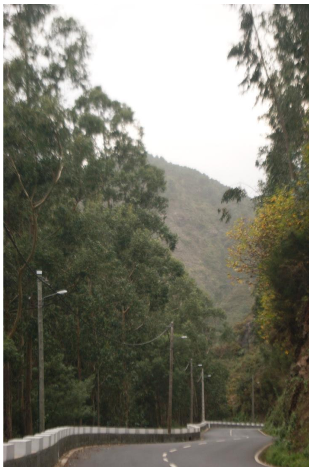
Figura 22. Estrada regional 107. - Imagem do autor
