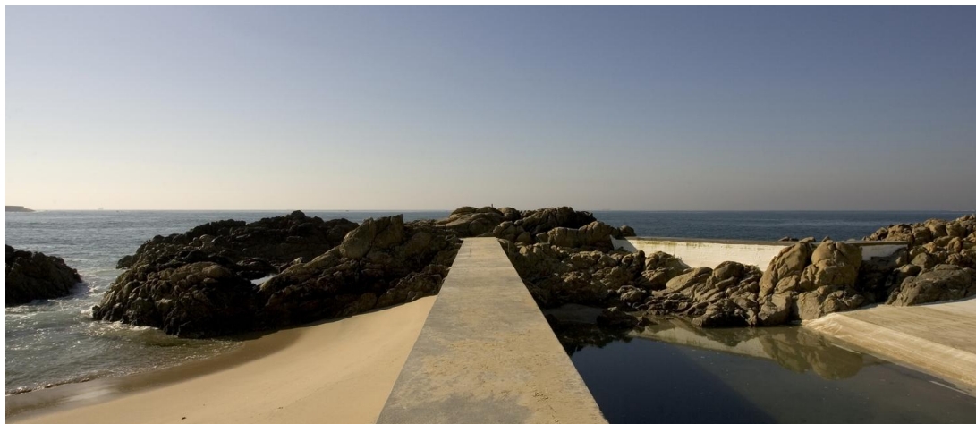
Figura 38. Muro de contenção Piscina das Marés. - Fernando Guerra
