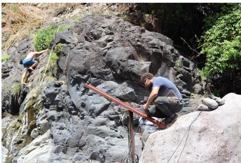
Figura 33. Voluntário soldando a estrutura da barragem. Ao fundo um visitante escala a parede de rocha sobre a água. - Imagem do autor
