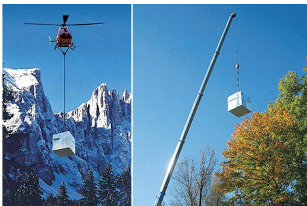
fig. 83 – exemplos de transporte de uma habitação, possibilitada através de helicóptero, que através de uma grua.
