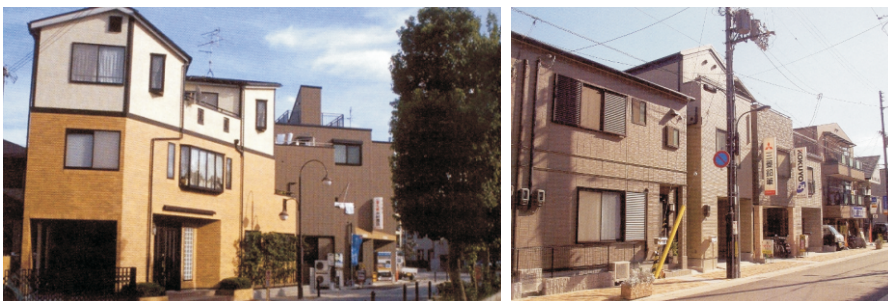
fig. 49 e 50 resp. – casas modulares prefabricadas, Kobe, Japão
