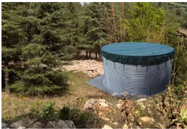
Figura 4.4.3 Cisterna de aço galvanizado
