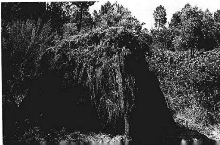
Figura 2.3.7 Abrigo fixo de materiais vegetais de planta quadrangular, Serra da Estrela, (Construções Primitivas em Portugal, 1988)
