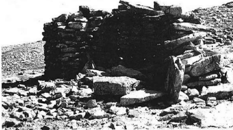
Figura 2.3.6 Abrigo Colina curva, Serra da Estrela, (Construções Primitivas em Portugal, 1988)
