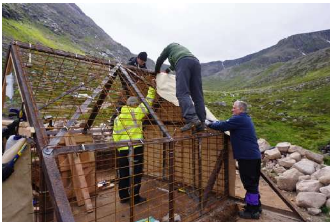
Figura 4.4.4 Estrutura de aço do Garbh Choire Refuge
