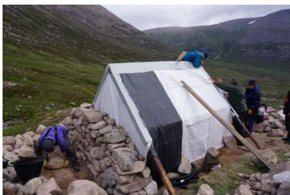
Figura 4.4.2 Garbh Choire Refuge, aplicação da membrana de borracha butílica.
