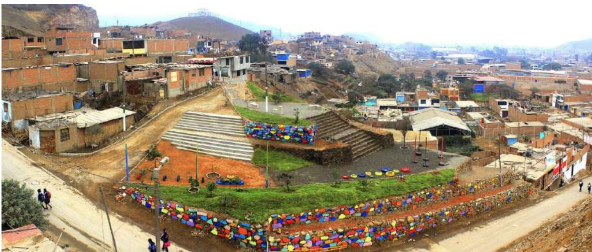
Figura 21 - Vista parcial da intervenção, Lima. (Archivo REP-BM, s.d.)
