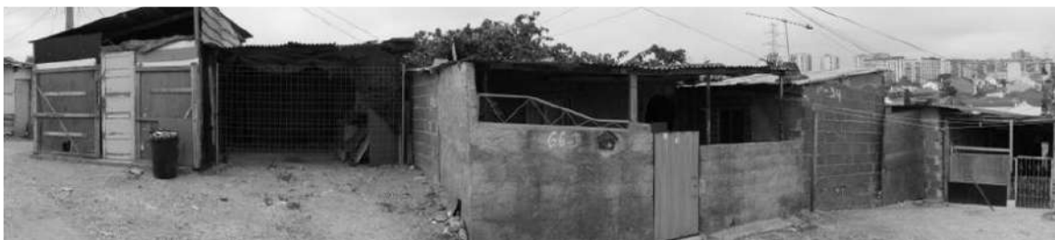
Figura 35 – Vista parcial de um dos arruamentos. (Amaral, 2014, p. 70)
