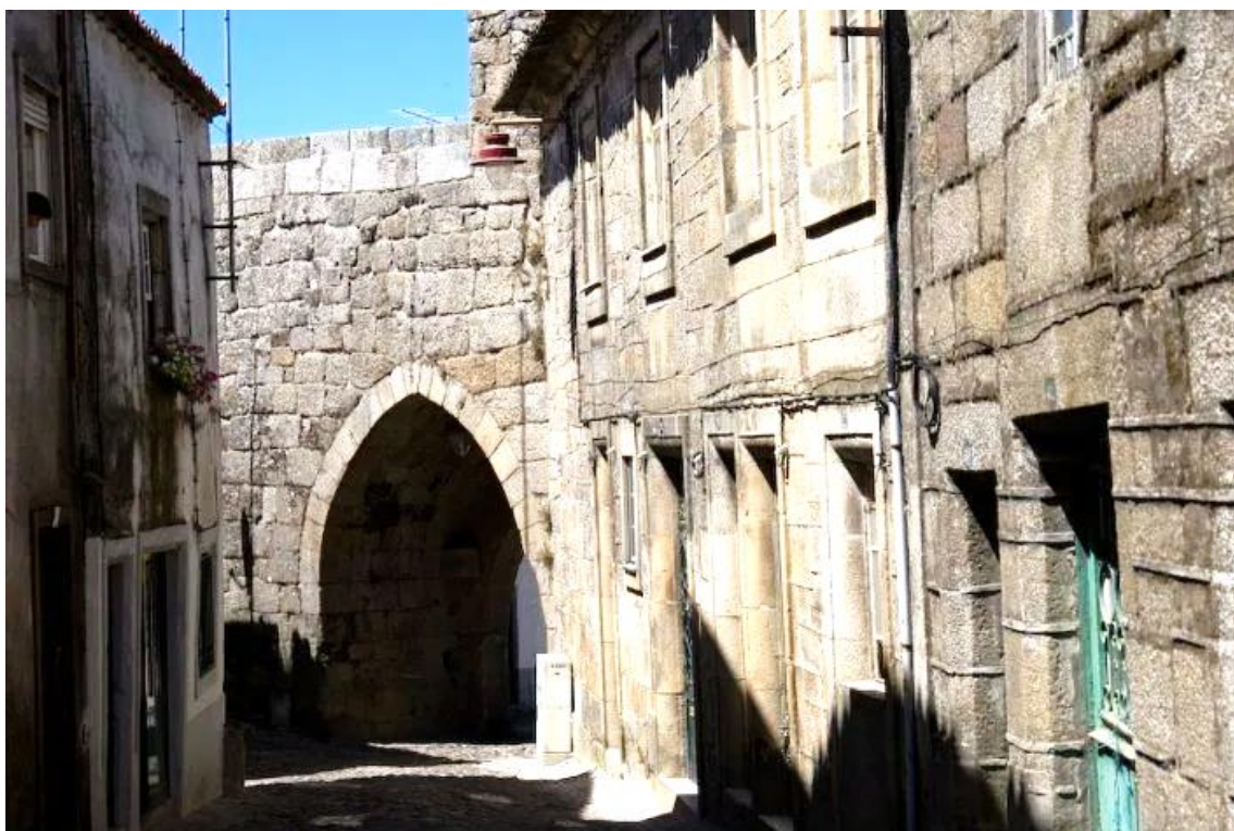
Figura 28- Edifícios existentes. (Sousa, 2021)
