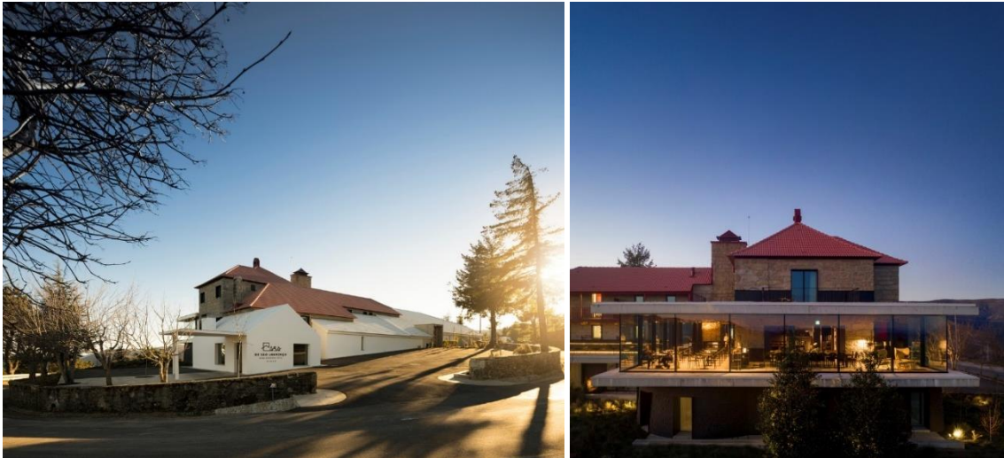
Figura 17- Fotografias do exterior do edifício. (FG+SG, 2018)
