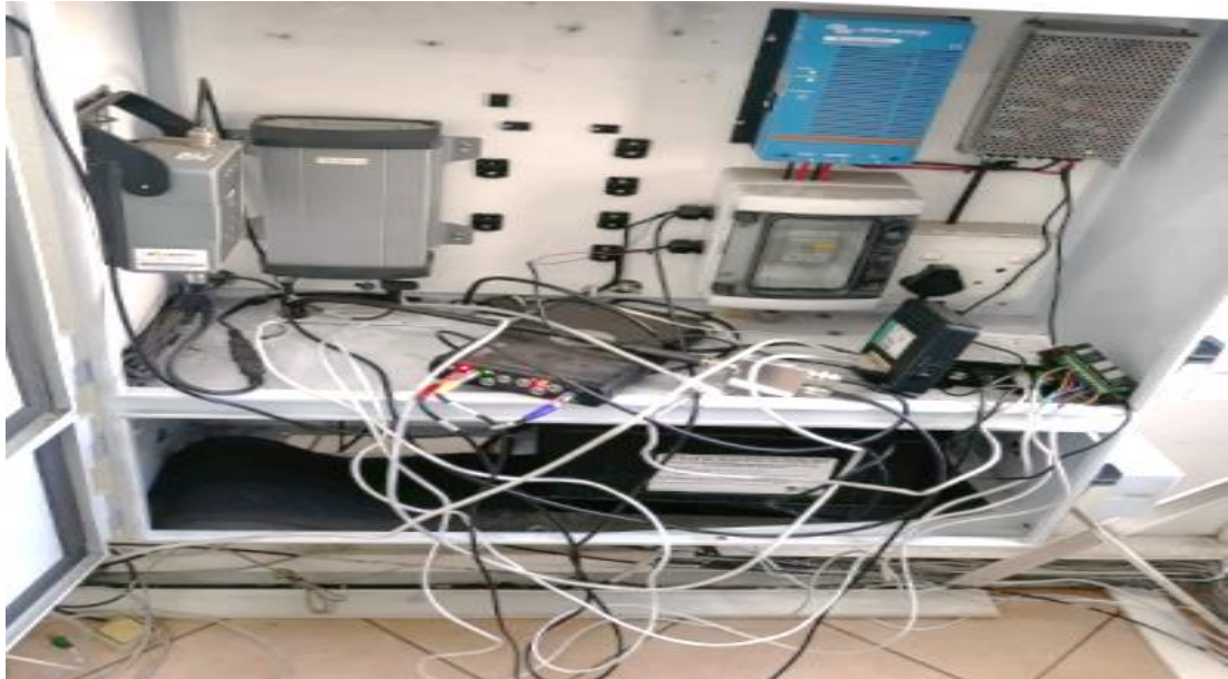
Figura 3. 4 – Componente Técnico da estação GNSS de MPTB instalada na CENACARTA.
