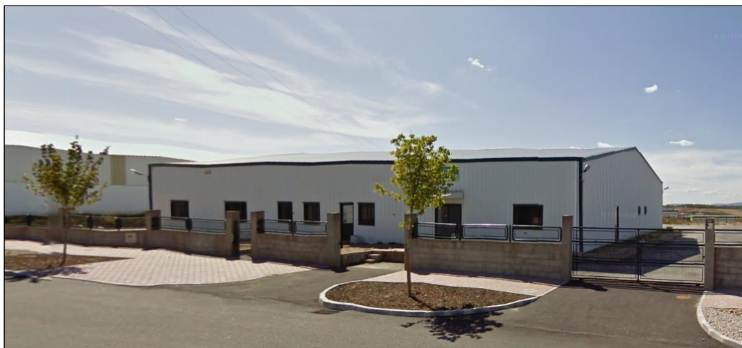
Figura 4.52 - Perspetiva da fachada da empresa C
