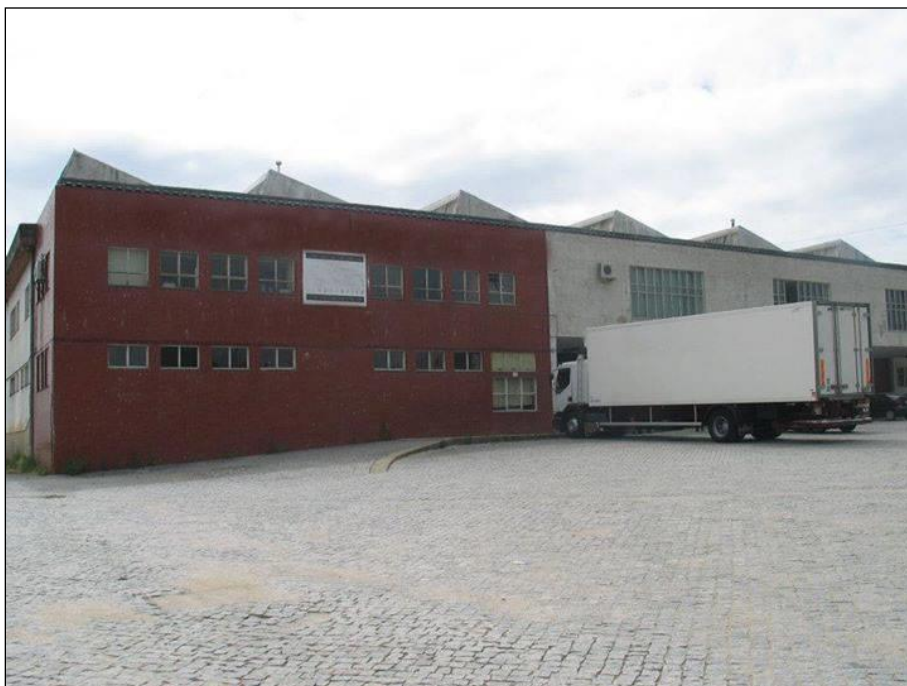
Figura 4.1 - Perspetiva da fachada da empresa A.
