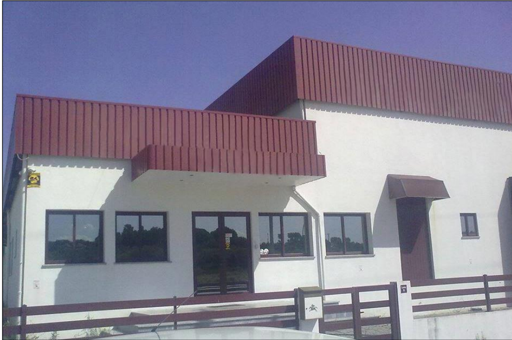
Figura 4.29 - Perspetiva da fachada da empresa B.
