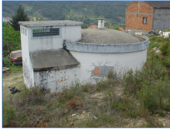
Figura 20 - Reservatório de distribuição de 100 m 3
