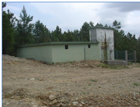
Figura 19 - Estação de tratamento e reservatório de armazenamento de 100 m 3
