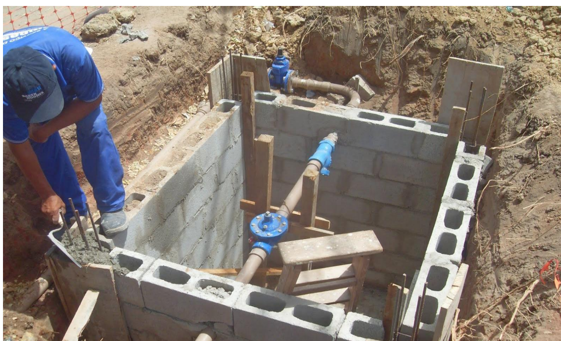
Figura 14 - Construção de uma Câmara de Manobras para instalação de uma VRP ( http://www.embasa.ba.gov.br/ , acedido 27/08/2011)
