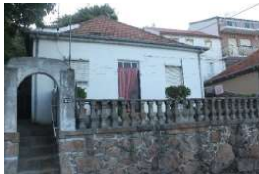
Edifício habitado no Bairro Municipal
