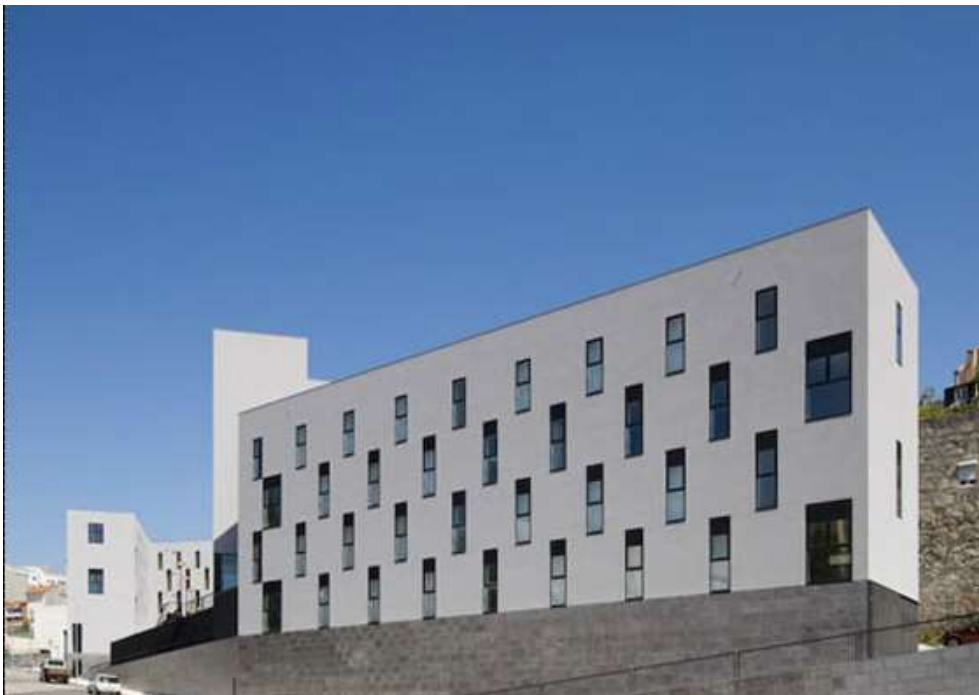
Figura 13- Vista do edifício Travessa dos Salgueiros
