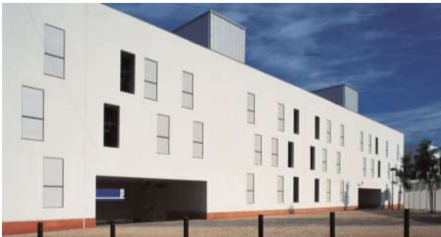
Figura 37- Vista do edifício a partir da Travessa Sargento Abílio.
