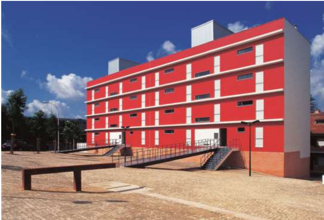
Figura 34- Vista de um dos edifícios.
