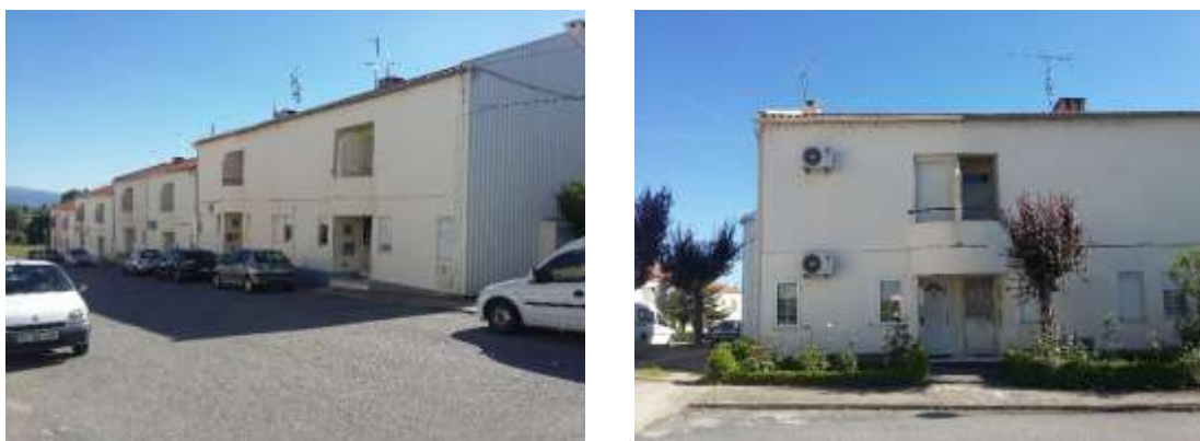
Figura 49- Edifícios do Bairro da Alâmpada.
