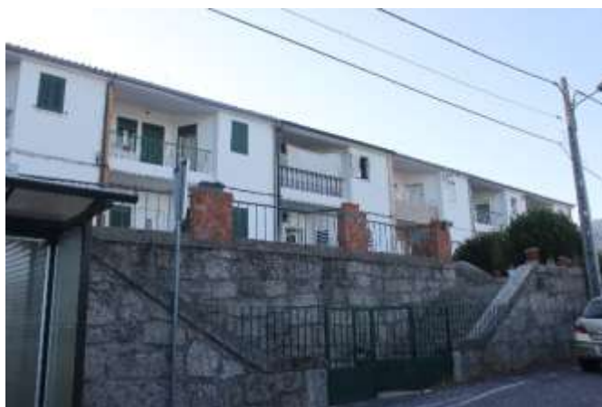
Figura 47- Edifícios do Bairro da Biquinha.
