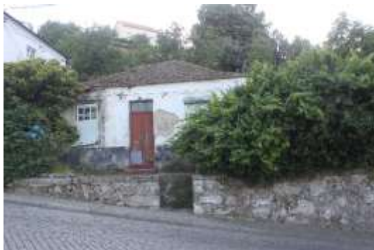
Edifício abandonado no Bairro Municipal.
