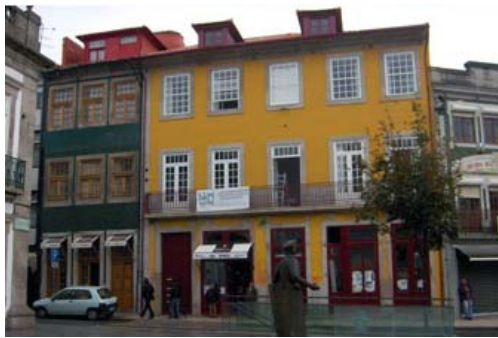
Figura 17. Edifício reabilitado, Porto
