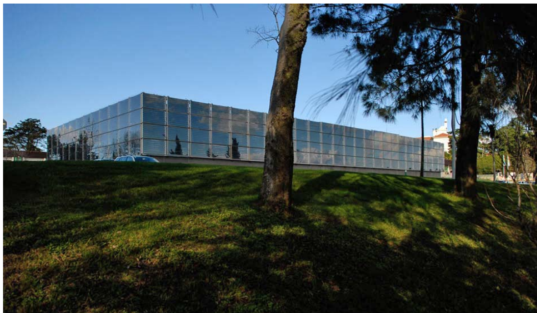
Figura 10. Centro de Controlo da Brisa, João Luís Carrilho da Graça.
