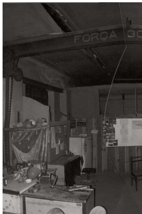
Figura 47. Interior da antiga estação elevatória antes da intervenção.
