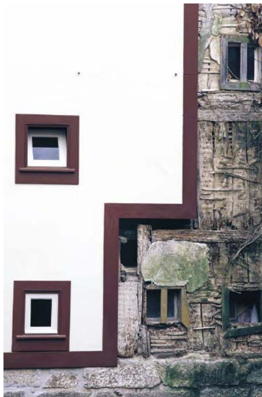
Figura 16. Pormenor de uma fachada recuperada.
