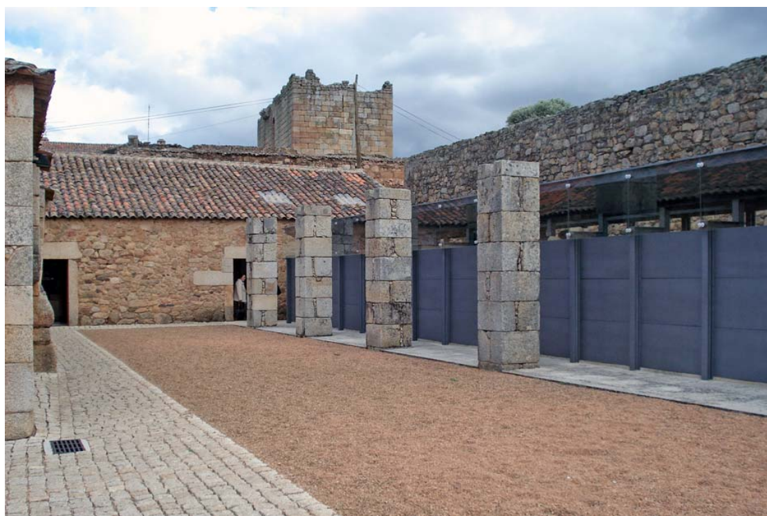
Figura 58. Vista para o antigo Lagar de Varas e para o novo Arquivo Epigráfico. Neste caso verifica-se um contraste entre o passado e o presente arquitectónico, elemento criado após a reabilitação da aldeia.
