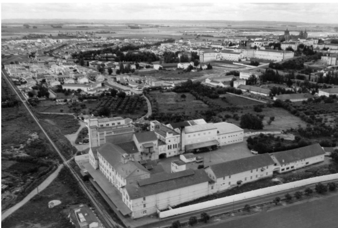
Figura 26. Conjunto da antiga Fábrica dos Leões.
