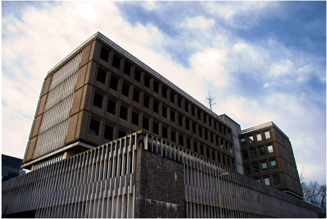
Figura 62. Ashburton Court, Hampshire. Antes das obras de reabilitação.
