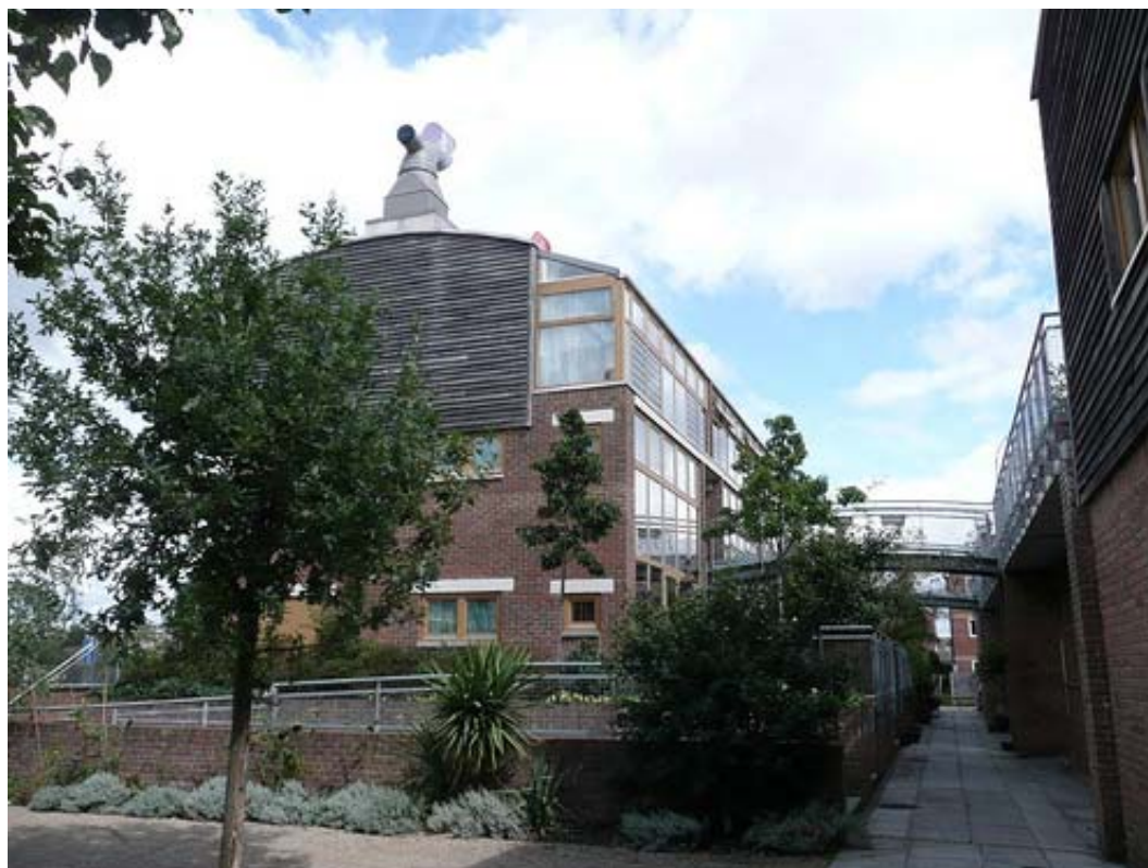
Figura 7. Vista para o conjunto habitacional e para os espaços comuns.
