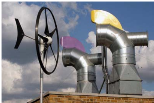
Figura 5. Pormenor de uma micro turbina eólica e do sistema de ventilação passiva.
