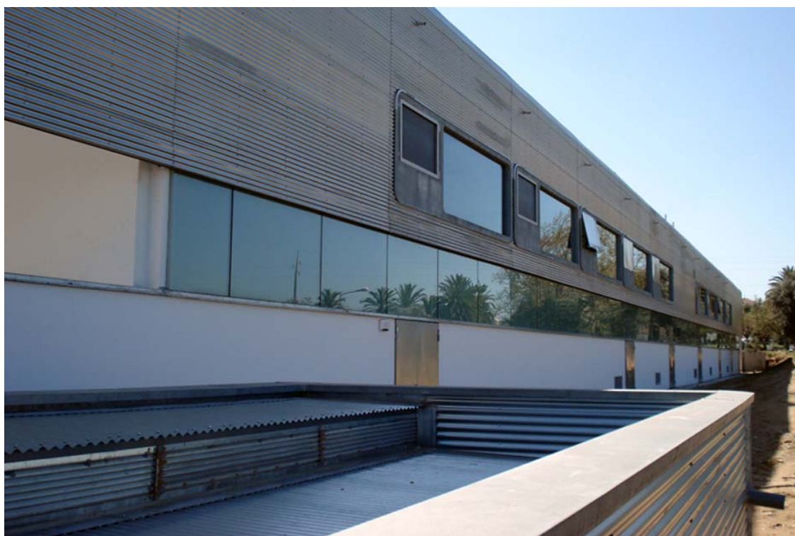
Figura 39. Fachada do volume orientada a Noroeste. Verifica-se um maior número de vãos orientados a Noroeste para aproveitar a luz difusa nos espaços de trabalho.
