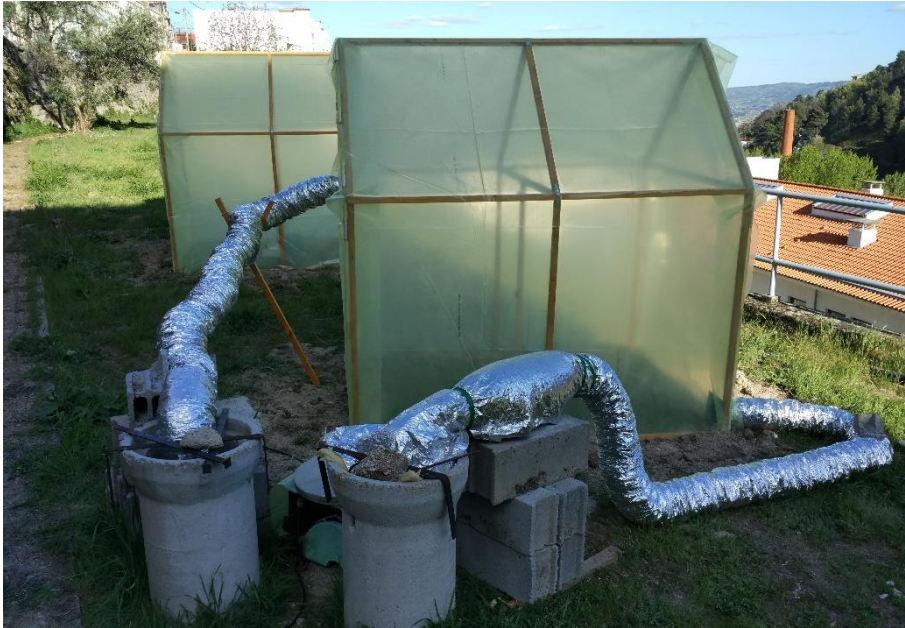
Figura 3.23 - Fotografia lateral da instalação
