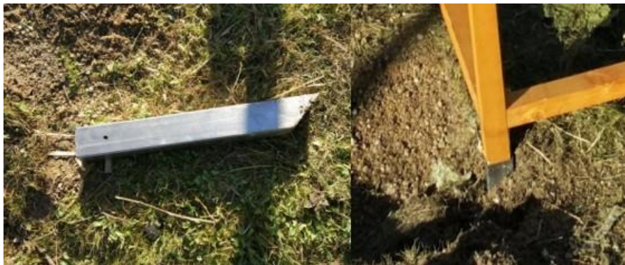
Figura 3.5 - Fotografia dos pormenores de fixação com o tubo de aço
