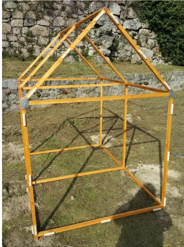
Figura 3.10 - Fotografia da distribuição do sistema de fixação do plástico
