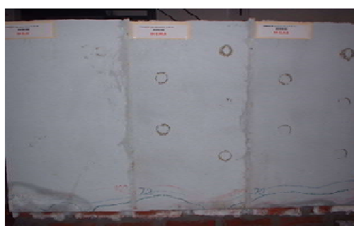
Umidade e eflorescências após 48h
