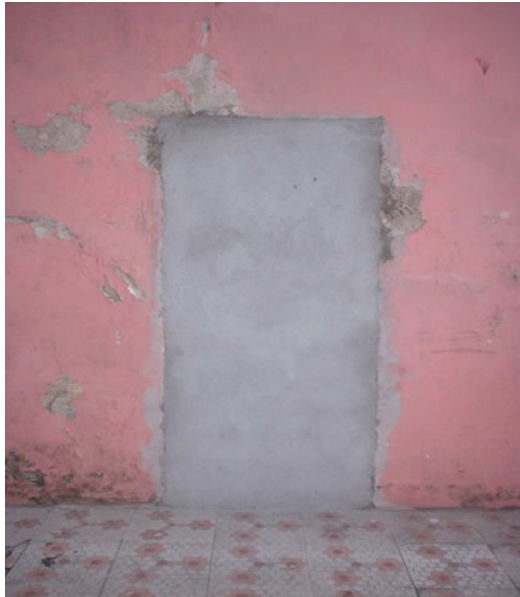
Figura 7.85 -Painel externo executado no edifício selecionado
