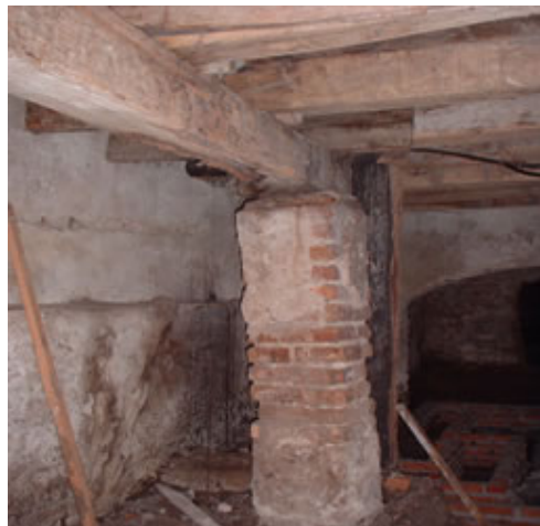
Figura 4.22 - Murete e sustentação dos barrotes
