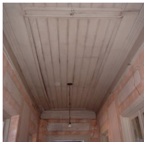
Figura 4.24 - Teto em madeira
