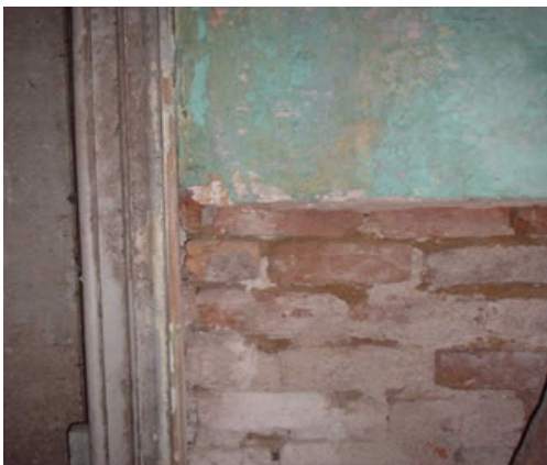
Figura 4.14 - Paredes em tijolos de barro
