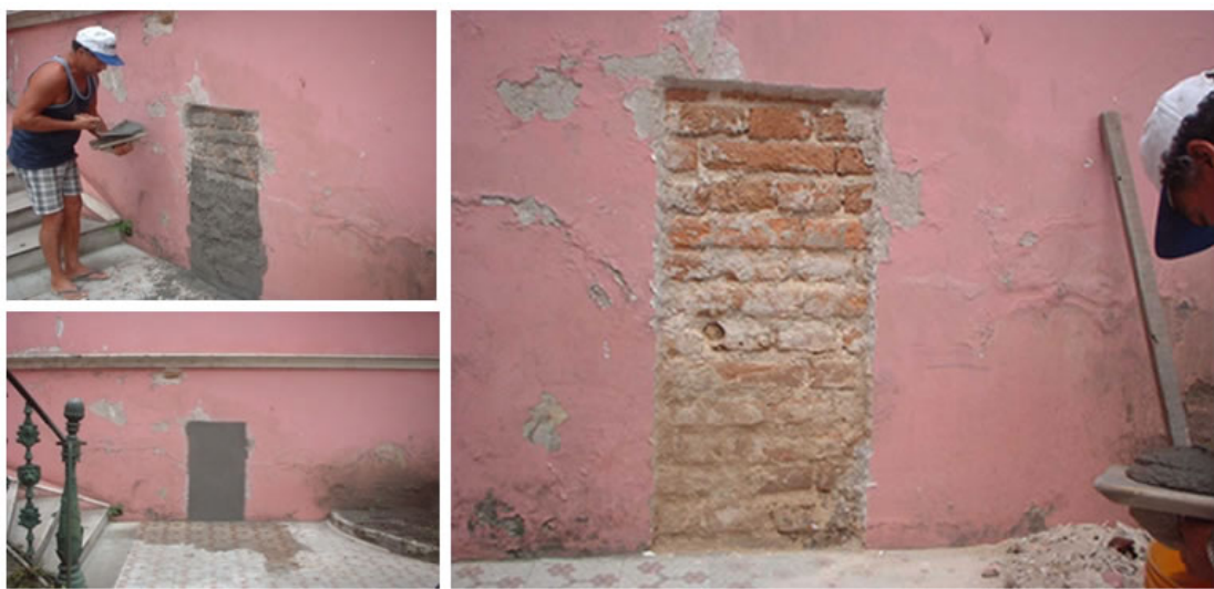
Figura 6.2 - Execução dos revestimentos experimentais no edifício selecionado (exterior)
