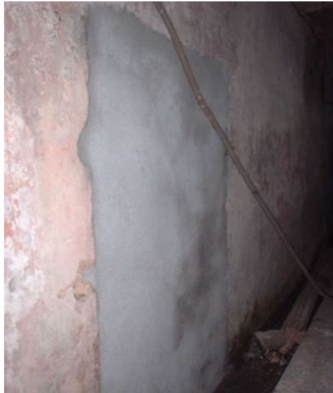
Figura 7.86 -Painel interno executado no edifício selecionado
