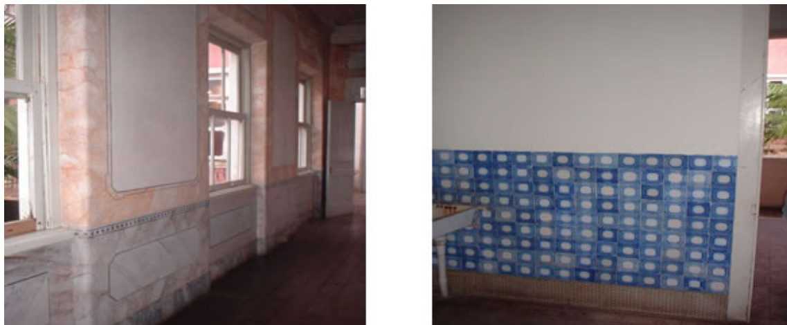
Figura 4.17 - Revestimento em escaiola e azulejos (respectivamente)
