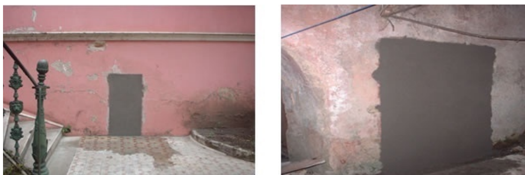
Figura 7.84 - Painéis executados no edifício selecionado, respectivamente exterior e interior
