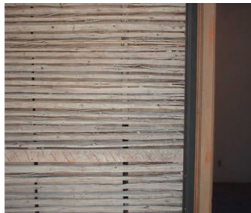
Figura 4.15 - Paredes em estuque
