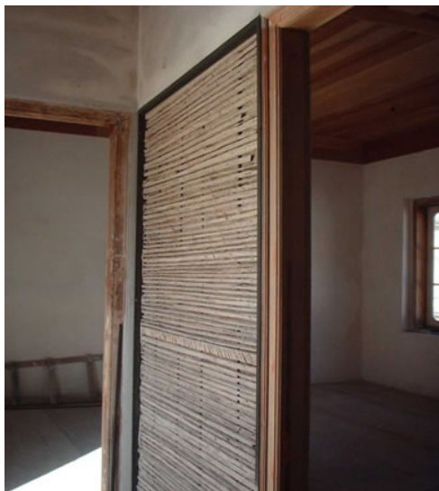
Figura 1.1-Parede de divisória em pau-a-pique - Edifício antigo
