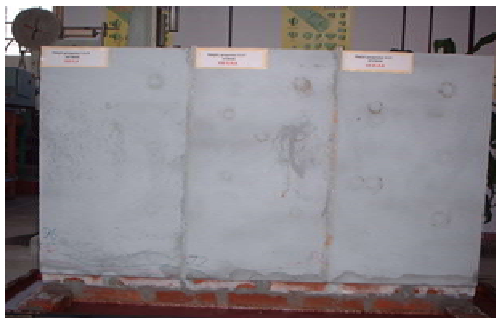
Umidade e eflorescências após 48h
