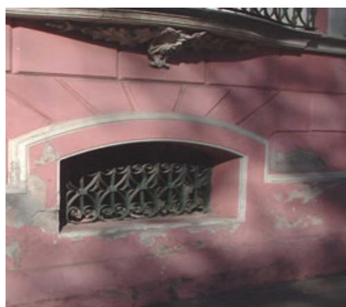
Figura 4.12 - Detalhe da caixa de ventilação (gateira)
