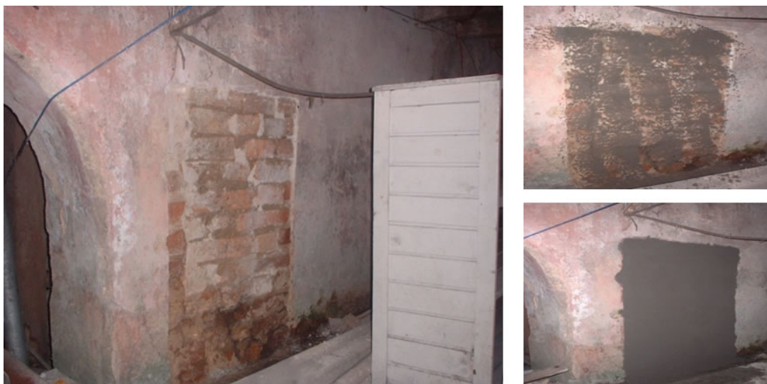
Figura 6.3 - Execução dos revestimentos experimentais no edifício selecionado (interior)
