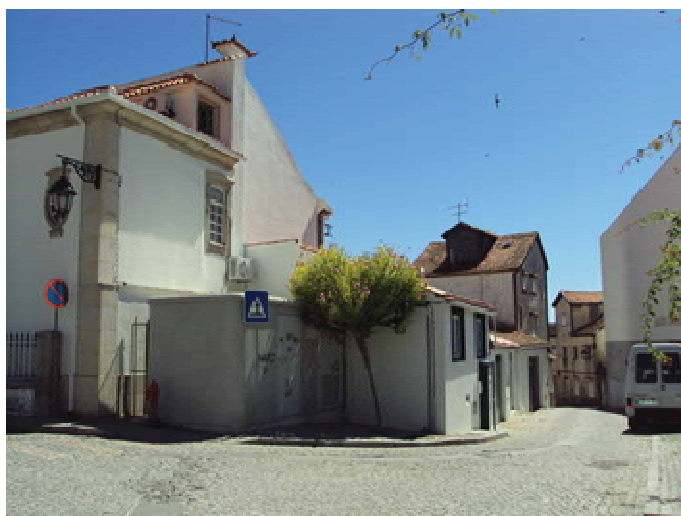
Foto 7 - Fachada da R.Castelo /Nascente
