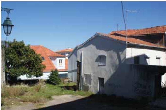
Foto 6 - Fachada interior a Poente
