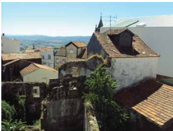
Foto 8 - Tardoz do edifício Brasonado
