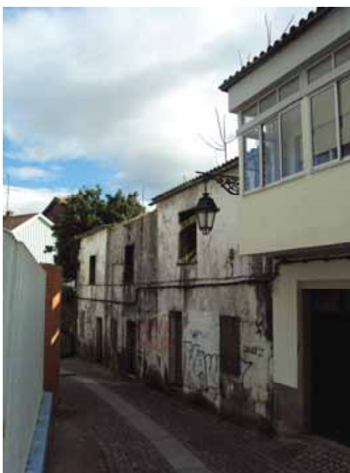
Foto 10 - Fachada da Travessa da Paciência /Norte
