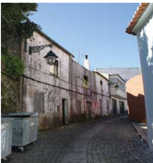
Foto 6 - Fachada da Travessa da Paciência / Norte
