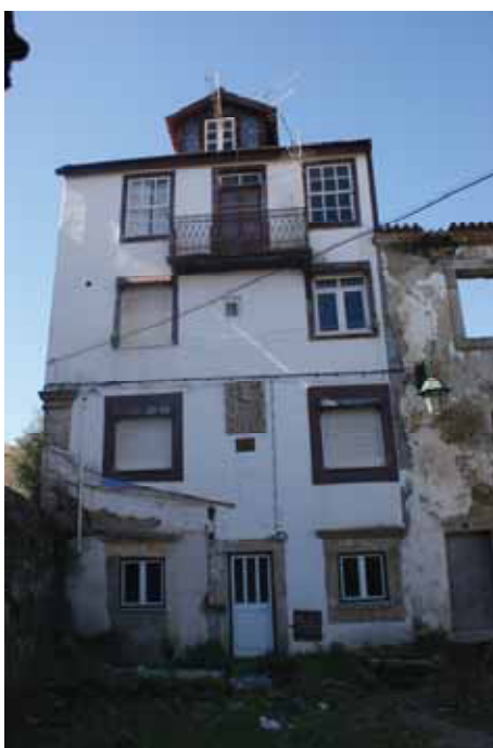
Foto 4 - Fachada do edifício brasonado /Nascente
