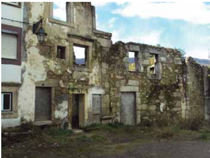
Foto 3 - Fachada do interior do pátio
