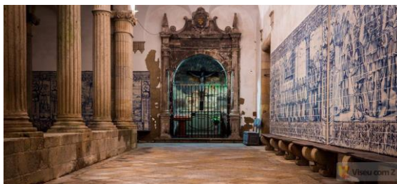
Fig.47 Corredor do Claustro da Sé
