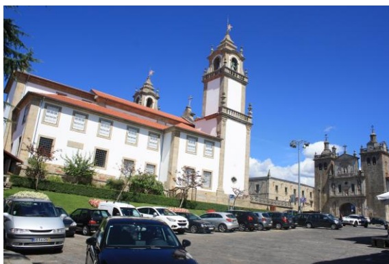
Fig.60 Estacionamento no Largo da Misericórdia
