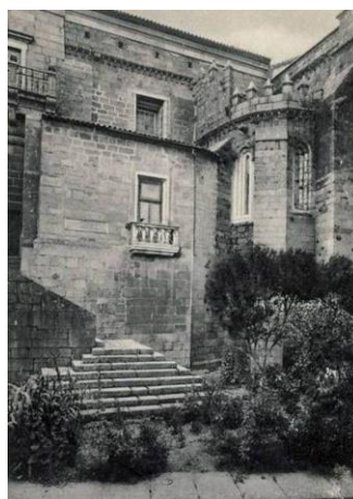
Fig. 40 Fachada posterior da Sé
