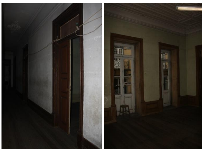
Fig.118 Pormenor das portas e janelas
