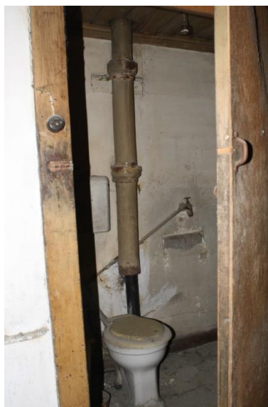
Fig.102 Instalação Sanitária - Piso 3
