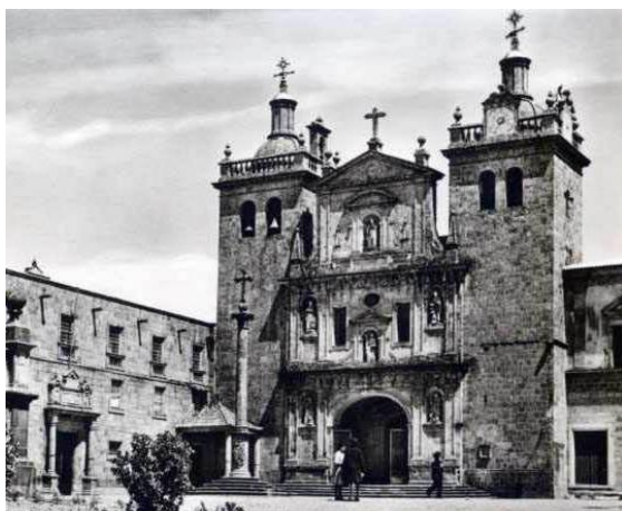
Fig. 39 Fachada principal da Sé
