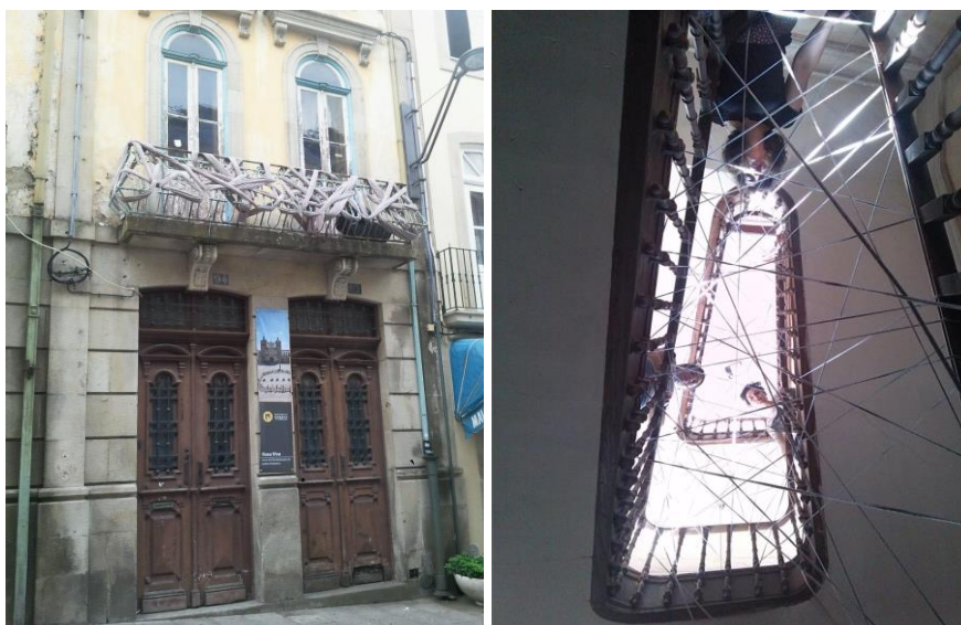
Fig.85 Intervenção no edifício nº 92 a 106 do projeto Casa de Sonho
