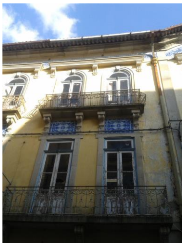
Fig.111 Pormenor dos painéis de azulejos na fachada principal
