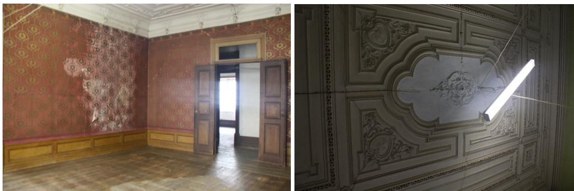
Fig. 115 Revestimento da parede interior da sala principal do piso 1 e do teto da sala principal adjacente
