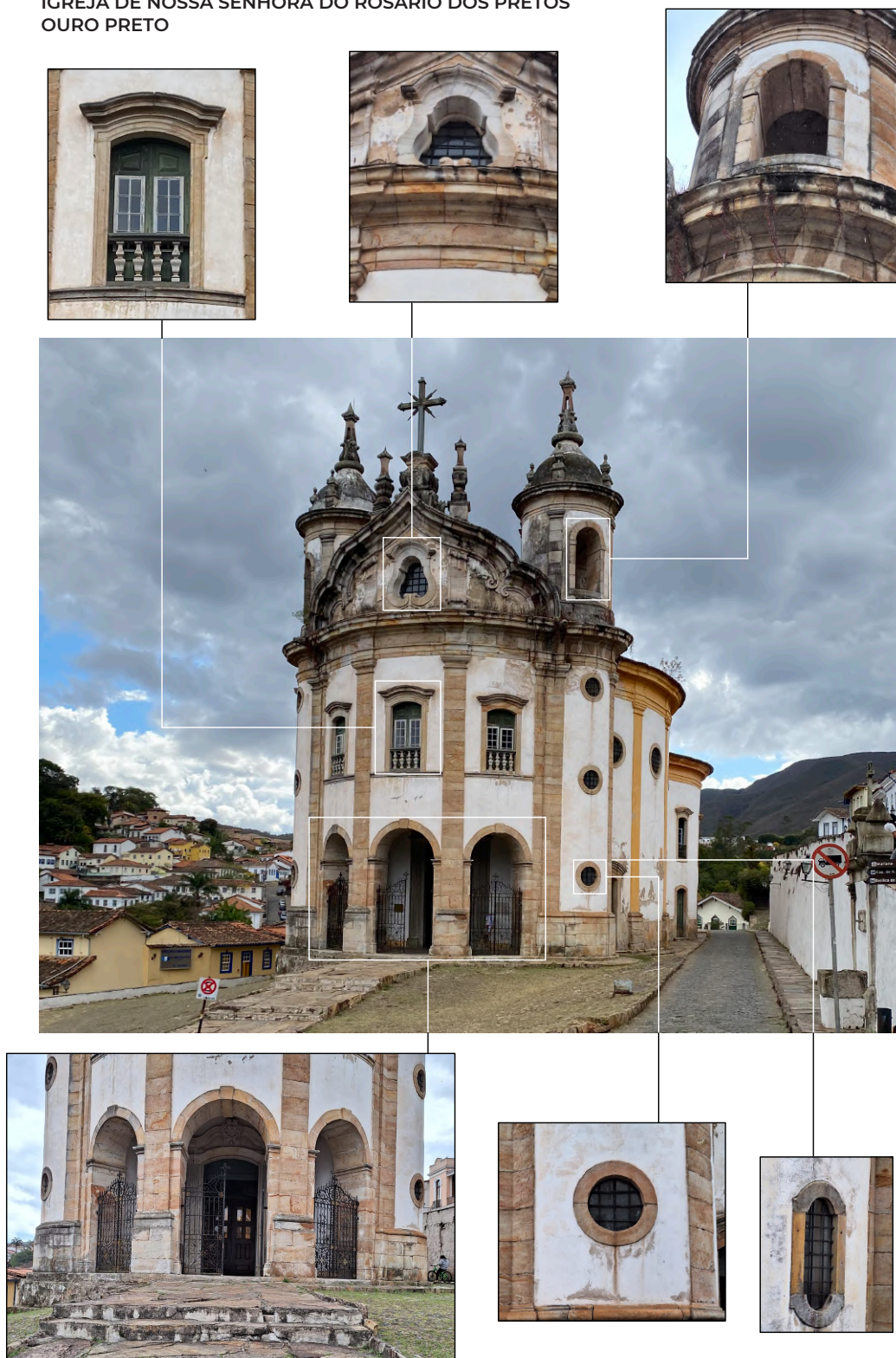
Figura 59. Vãos do frontispício de Nossa Senhora do Rosário dos Pretos de Ouro Preto. (Autora, 2023)
