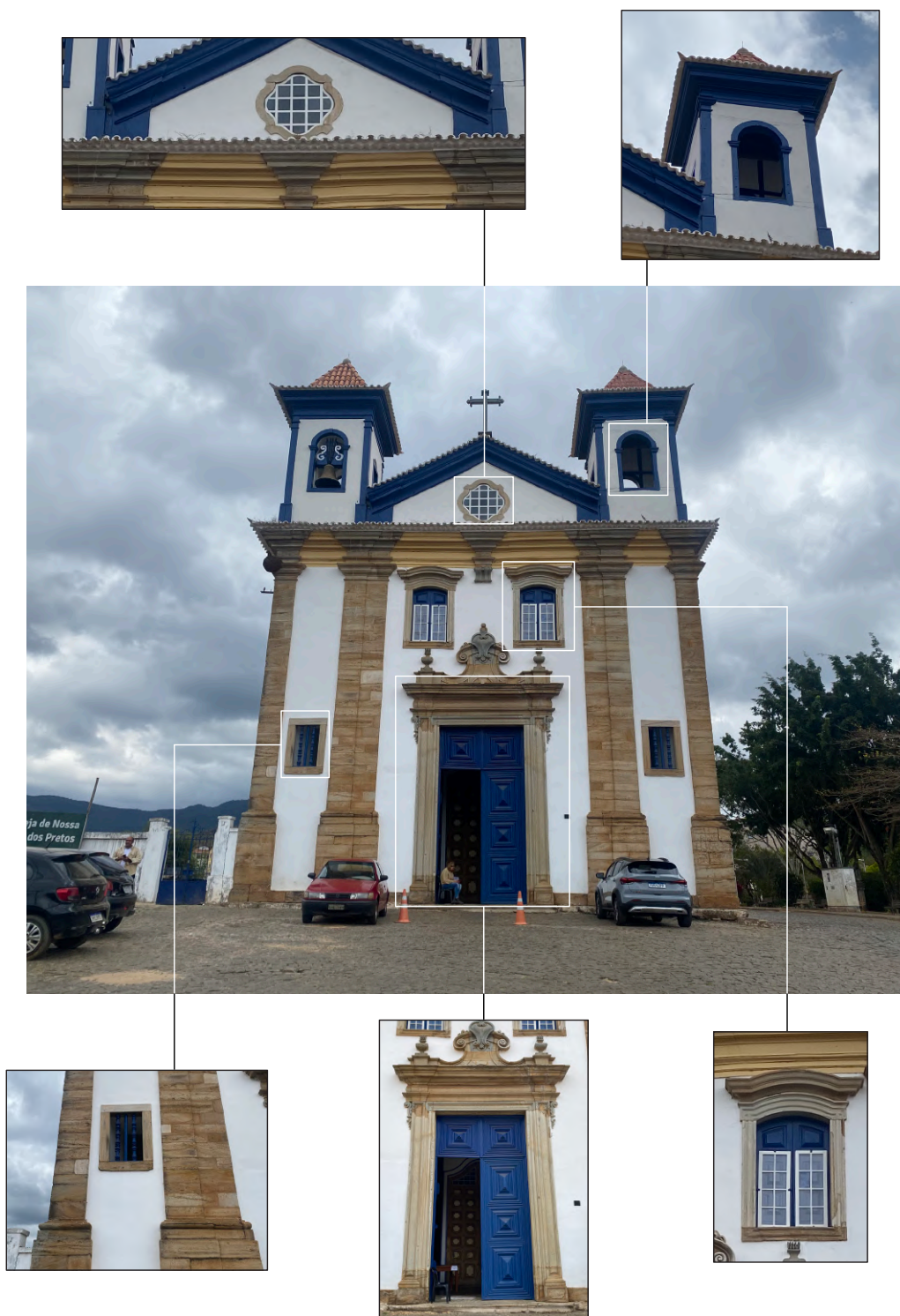
Figura 56. Vãos do frontispício de Nossa Senhora do Rosário dos Pretos de Mariana. (Autora, 2023)
