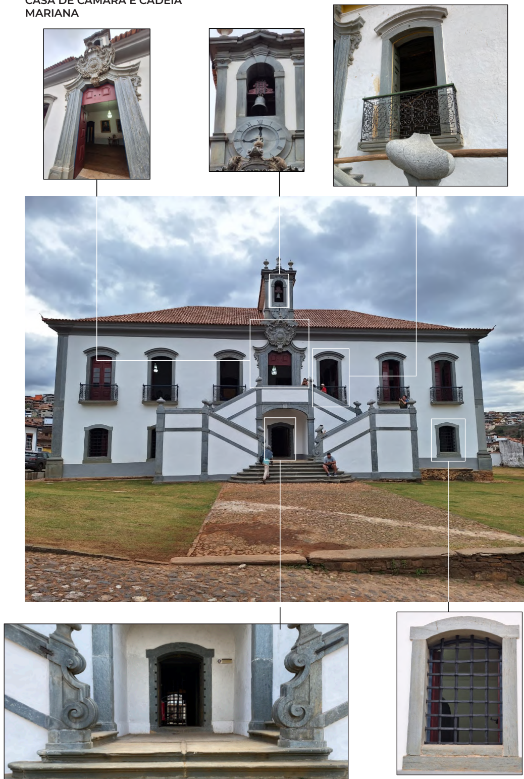
Figura 54. Vãos do frontispício da Casa de Câmara e Cadeia de Mariana. (Autora, 2023)
