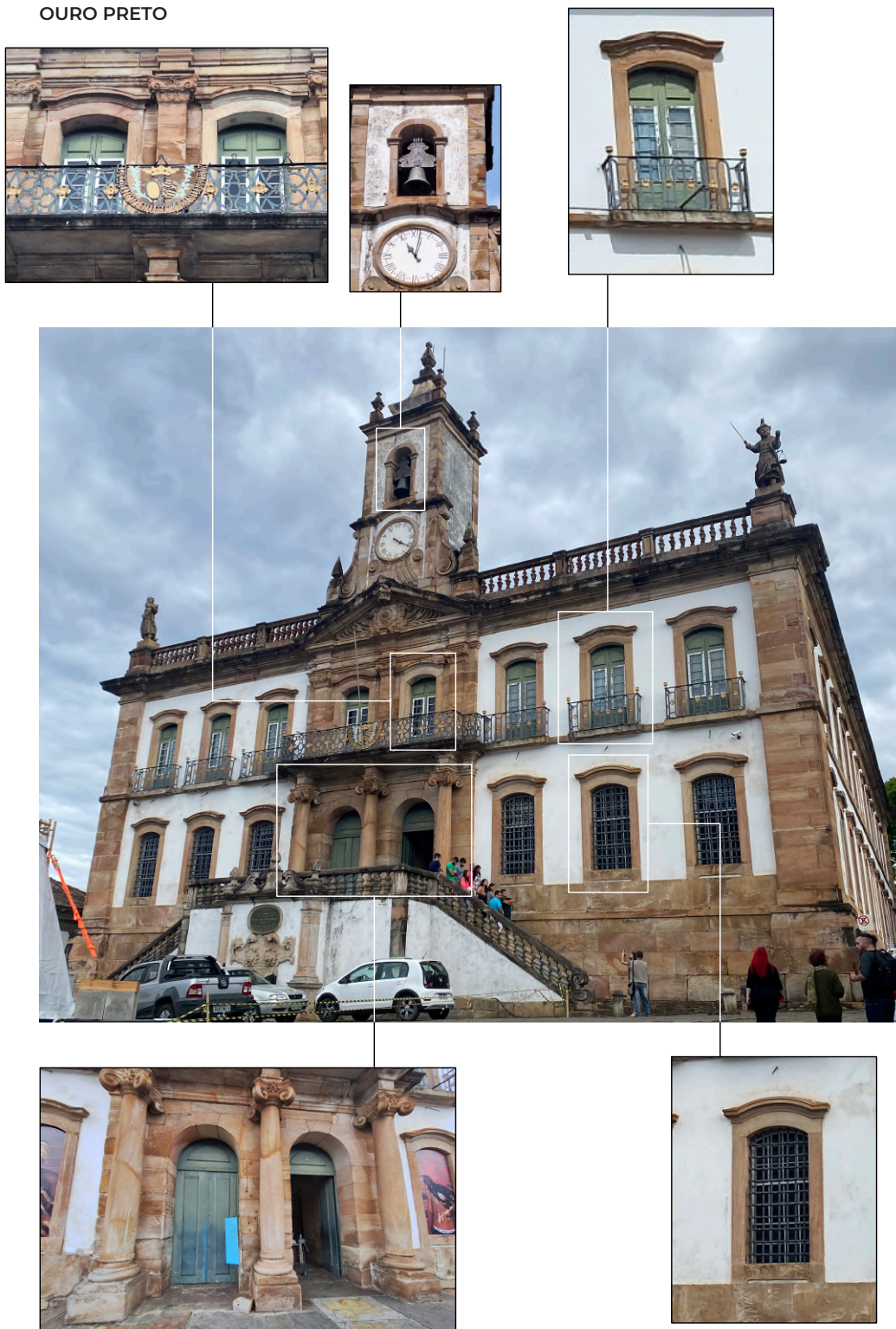
Figura 57. Vãos do frontispício da Casa de Câmara e Cadeia de Ouro Preto. (Autora, 2023)
