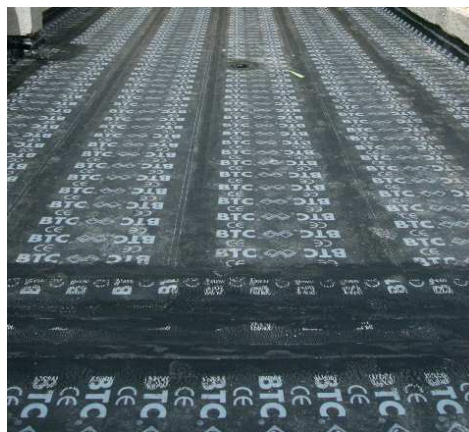
Figura 15 - Tela asfáltica já aplicada (Fonte: http://telaasfaltica.com )
