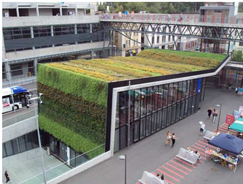
Figura 12 - Cobertura e fachada ajardinada no Jardim Lausanne, Suíça (Fonte: Jordi Serramia, partilhado publicamente)
