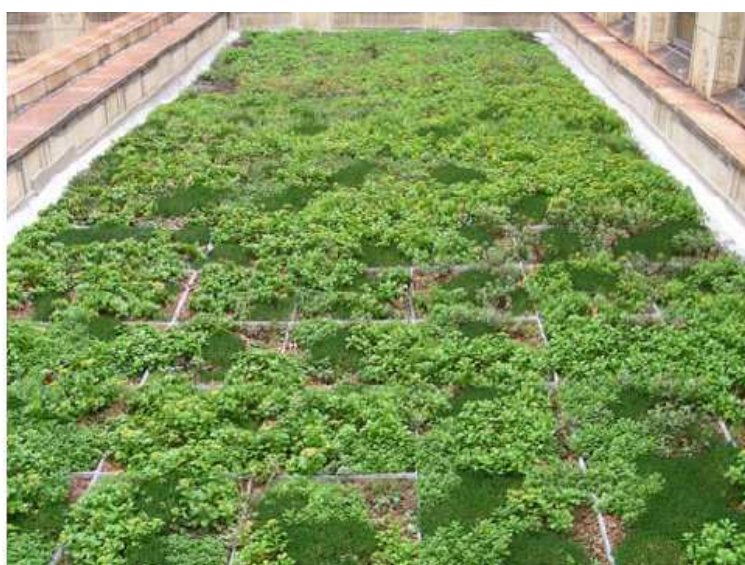
Figura 37 - Telhado já com os módulos plantados (Fonte: Green Roof Blocks™)
