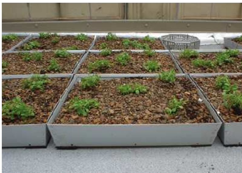
Figura 36 - Caixa de alumínio já plantada - (Fonte: Green Roof Blocks™)
