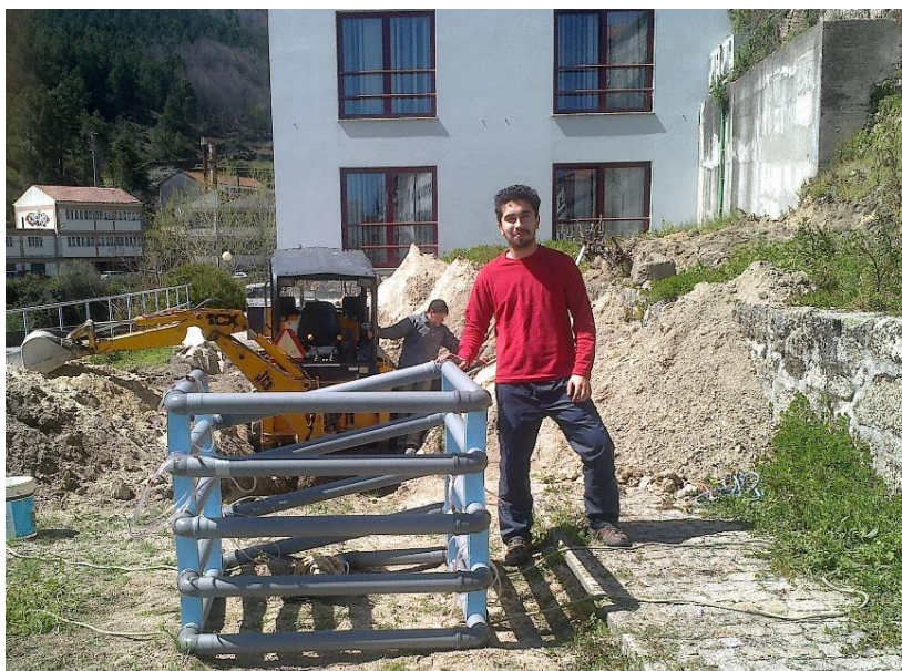
Figura 4.12 - Fotografia do permutador e do processo de escavação do buraco.
