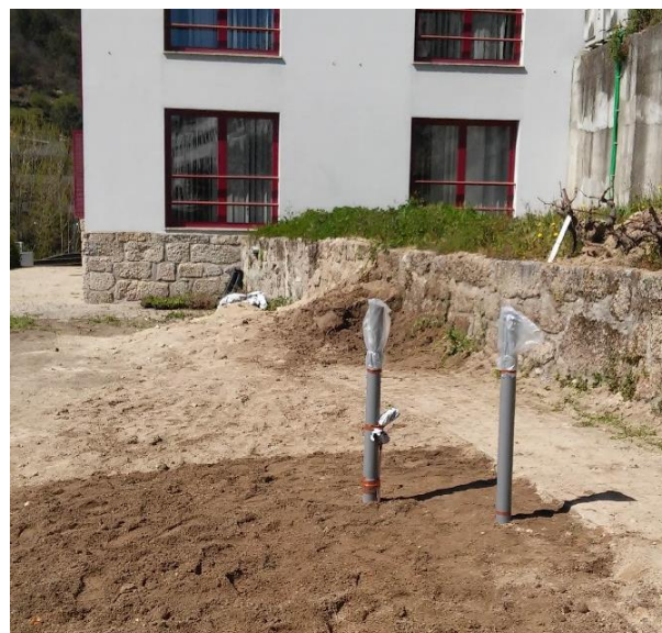
Figura 4.14 - Enterro do permutador e sua conclusão.
