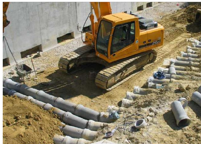
Figura 3.13 - Pormenores da instalação da tubagem (manilhas de cimento). Adaptado de INETI (2005).
