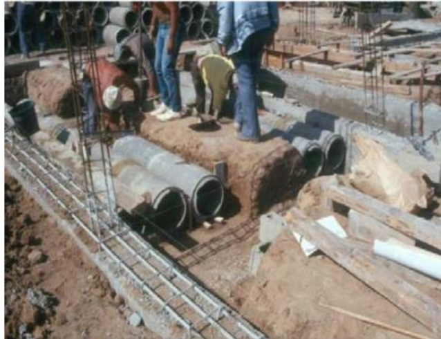
Figura 3.14 - Pormenores da instalação da tubagem (manilhas de cimento). Adaptado de Gomes (2010).
