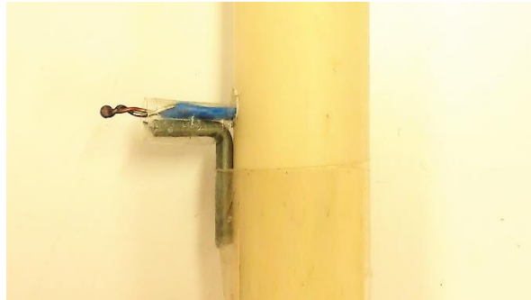
Figura 4.19 - Pormenores da aplicação de um apoio metálico.
