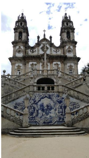
FIGURA 60 - Painel de azulejos
