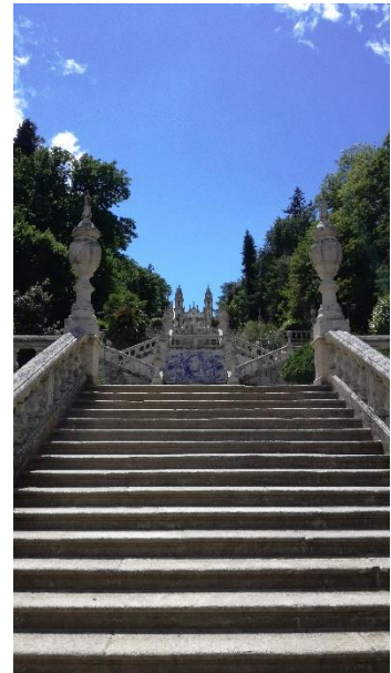
FIGURA 67 - Painel de azulejos
