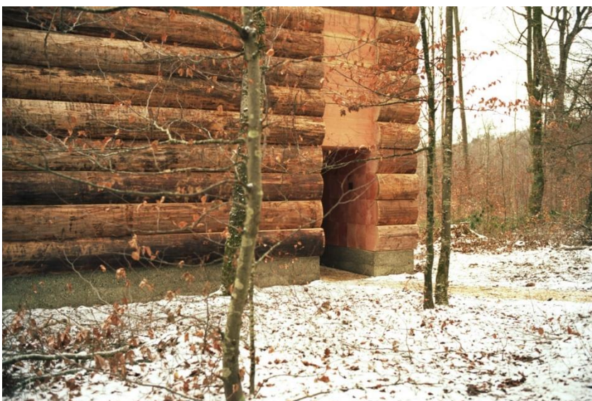
FIGURA 30 - Abertura para a porta de entrada - Exterior
