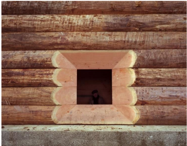
FIGURA 32 - Abertura para a janela
