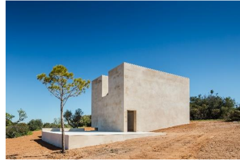
FIGURA 3 - Zona de entrada da capela do Monte
