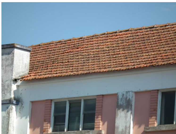
Figura 18 - Cobertura em telha cerâmica
