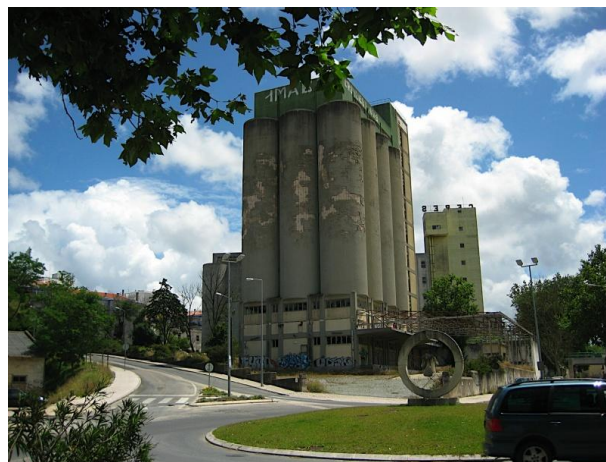
Figura 12 - Silos de moagem de cereais - Caldas da Rainha
