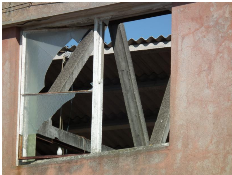
Figura 19 - Cobertura em painéis fibrocimento
