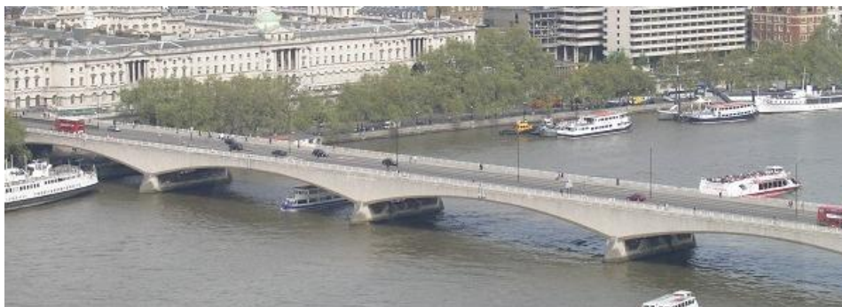
Figura 8.1 (a) - Vista geral da Ponte de Waterloo [45]
