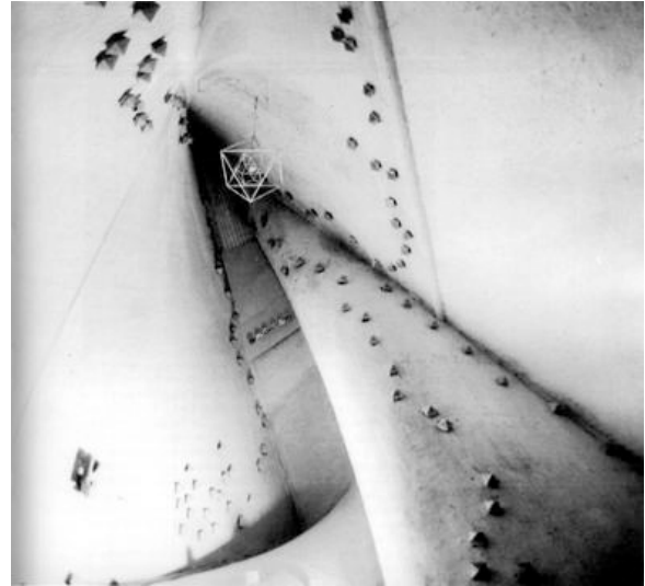
Fig. 51 - Pormenor do teto no interior do Pavilhão Philips
