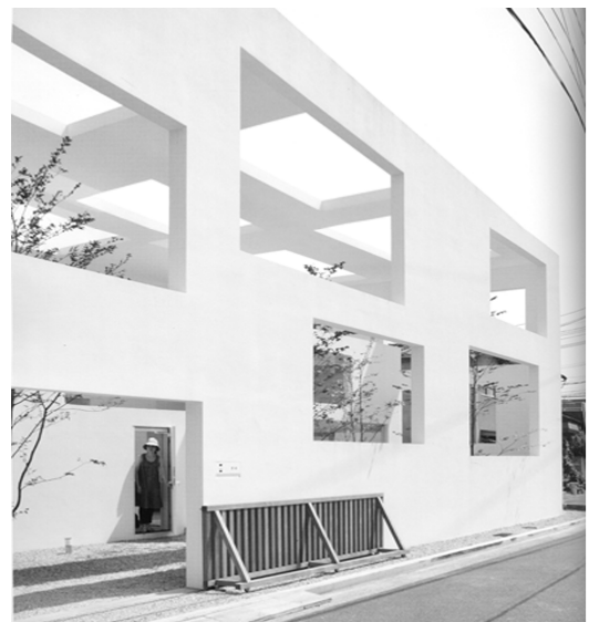
Fig. 32 - Exterior da Casa N, Sou Fujimoto, Japão
