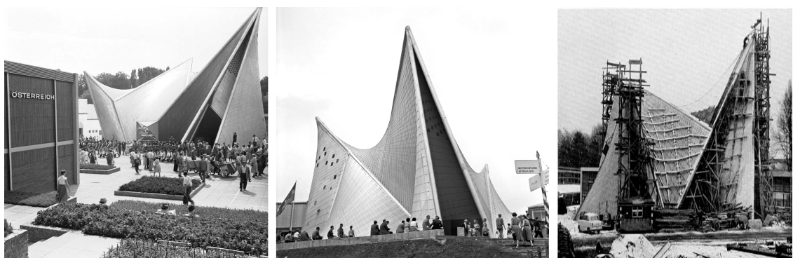
Fig. 54 - O edifício ergue-se como uma tenda. Três pontas criam as formas hiperbólicas, o revestimento exterior é composto por painéis de betão pendurados por cabos de aço criando uma textura que enfatiza o movimento das formas com as diferentes direções em cada plano.
