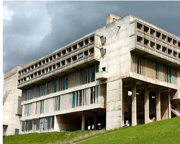
Fig. 15 - La Tourette (1953-56), Le Corbusier. Vista parcial do alçado sul com os vidros ondulantes desenhados por Iannis Xenakis.
