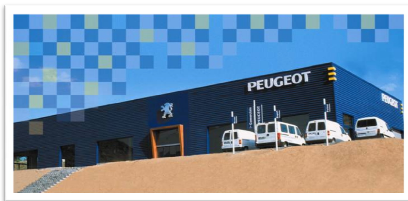
Figura 3. Edifício da Garagem D. José, Lda. em Vale de Estrela
