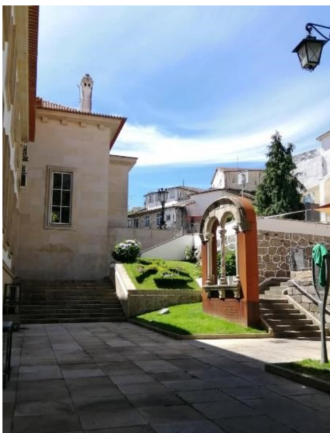
Figura 52 | Escadarias laterais da Câmara Municipal da Covilhã. Março, 2022.
