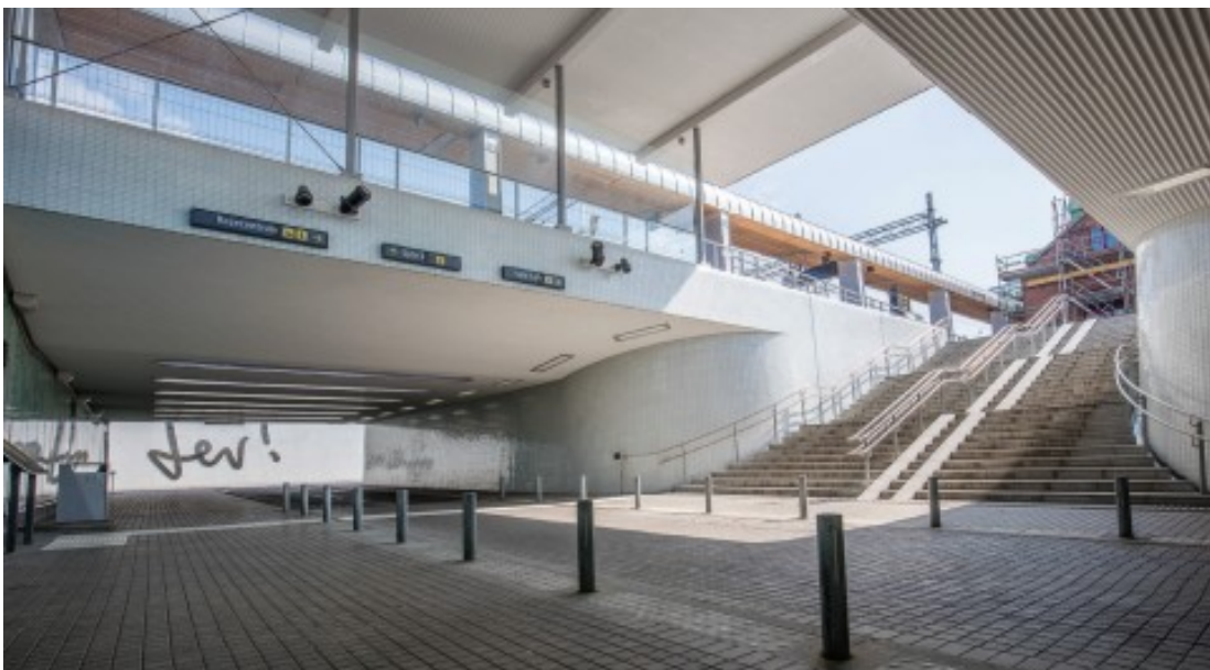
Figura 22 | Vistas dos acessos ao exterior do túnel. (Madariaga & Novella, 2021, p. 89)
