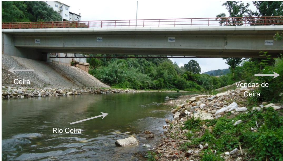
Fig. 4.8 - Localização da Ponte de Longra sobre o rio Ceira
