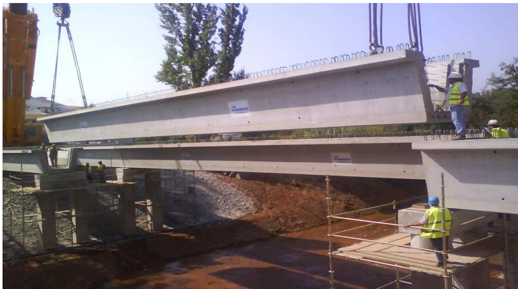
Fig. 4.9 – Posicionamento das vigas em U do tabuleiro (Fonte: www.cm-coimbra.pt )
