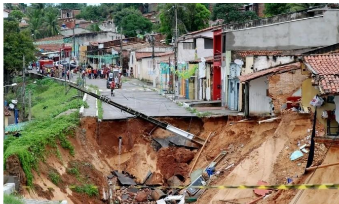
Figura 3 - Deslizamento de terra em Natal, Brasil (Ana Cristina Campos, 2014)
