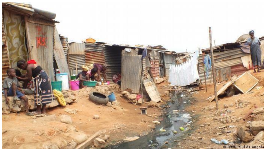
Figura 56- Sistema de escoamento de águas residuais e pluviais nos musseques (Thiago Melo, 2016)
