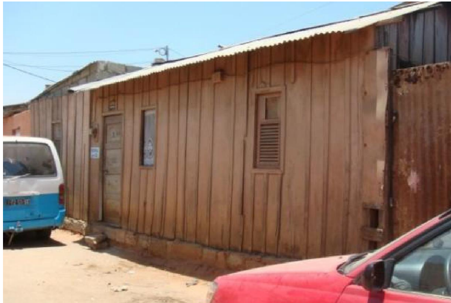
Figura 53 - Construção de madeira (Andrea Bettencourt, 2010)
