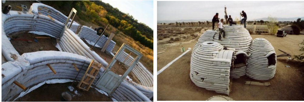
Figura 46 - Fase de execução (Calearth, 2011)
