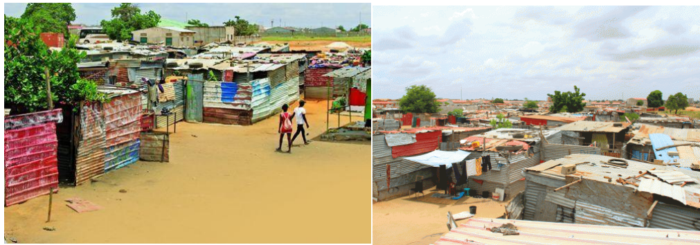
Figura 62 - Abrigos existentes a mais de 12 anos na zona do Zango O, Luanda, Angola (Cipra, 2023)
