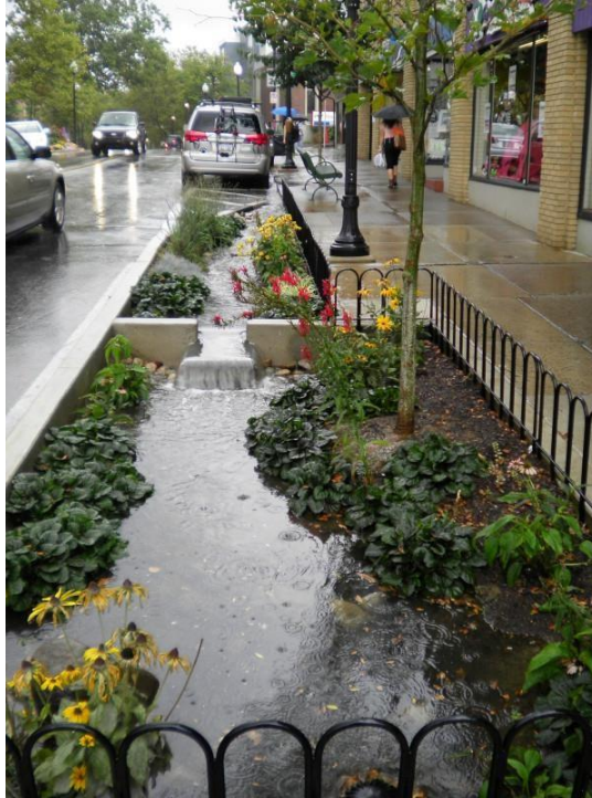
Figura 30- Sistema de Biorretenção (Engenharia360, 2020)
