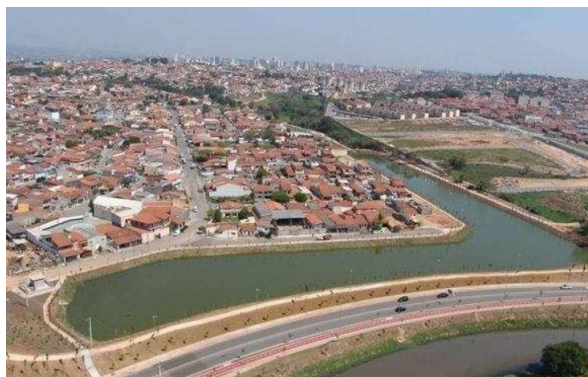
Figura 31- Lagos Pluviais (Engenharia360, 2020)
