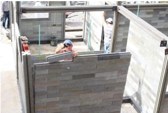
Figura 65 - Construção de plástico reciclado (Valencia, 2019)
