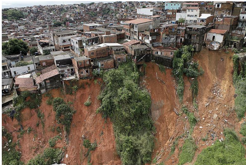
Figura 15 - Construção em zona de risco de deslizamento de Terra (Manu Dias, 2015)
