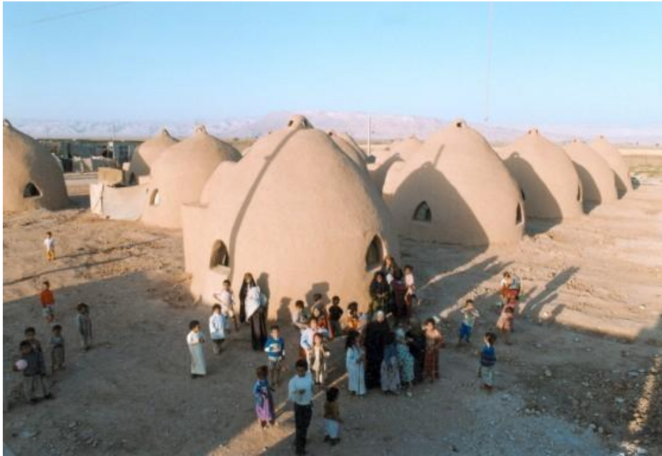
Figura 45 - A técnica de super adobe (Cal earth, 2011)
