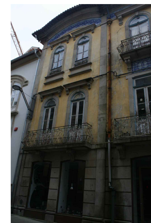
Pormenor da Fachada Principal
