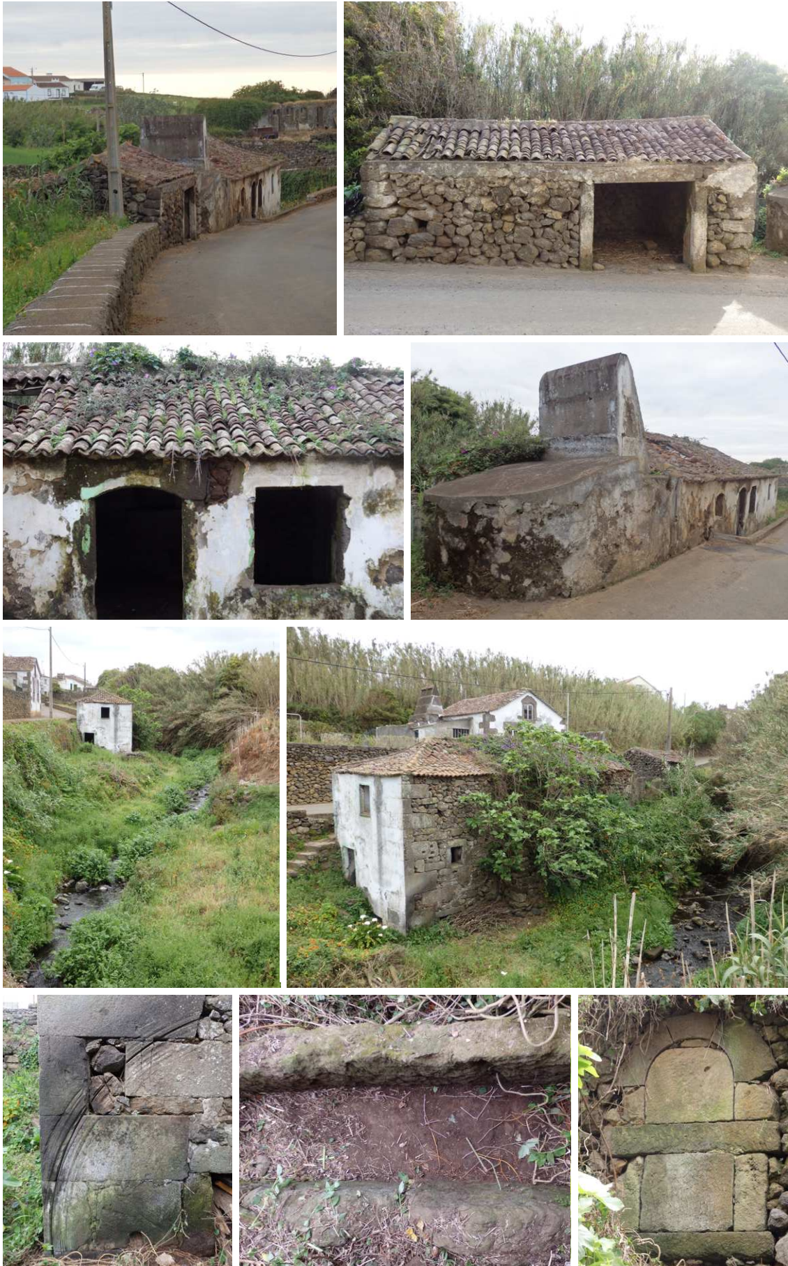
Figura 50 - Exterior do edificado. Fotografias da autora, 2018.
