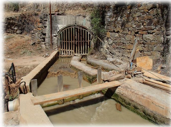
Figura 1.5 - Saída da Galeria da Salgueira.
