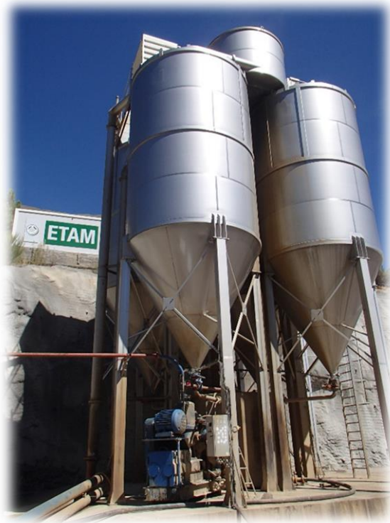
Figura 1.7 - Instalação de Tratamento de Águas da Mina.
