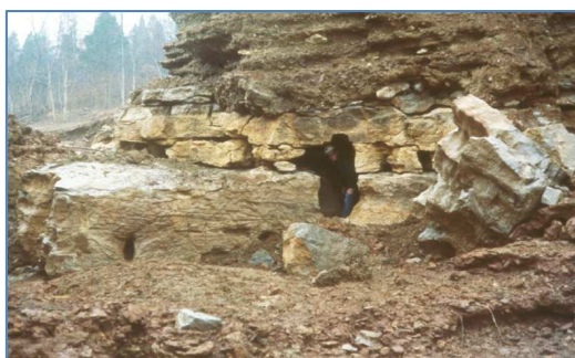
Figura 2-35 Galerias presentes na fundação da barragem de East Fork em Kentucky nos EUA (Schaefer, 2009).
