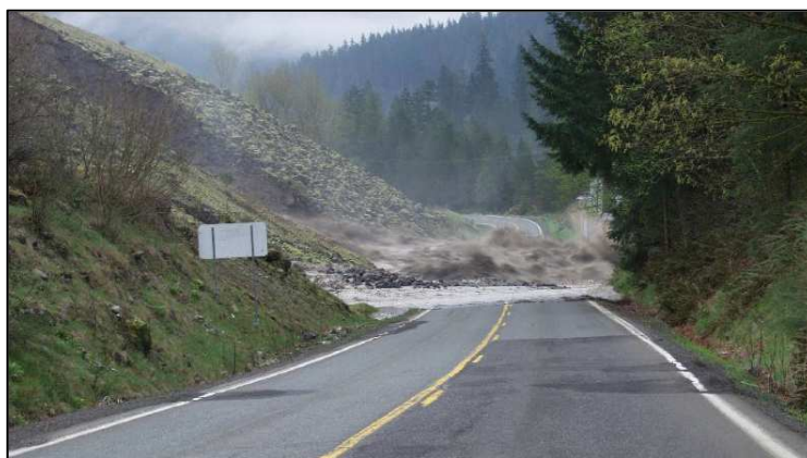
Figura 2-32 Imagem do início da rutura do talude e esvaziamento da albufeira de Canal Swift2 em Washington (Schaefer, 2009).
