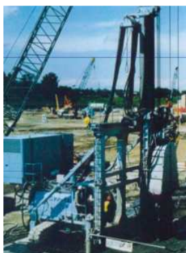
Figura 2-45 Equipamento de execução de TRD (Bruce, 1998)
