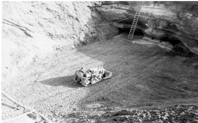
Figura 2-37 Remediação na Barragem de Wolf Creek (Schaefer, 2009).
