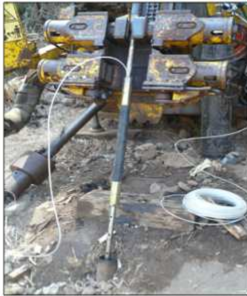
Figura 3-23 Aspecto geral aquando da execução do ensaio de Lugeon.
