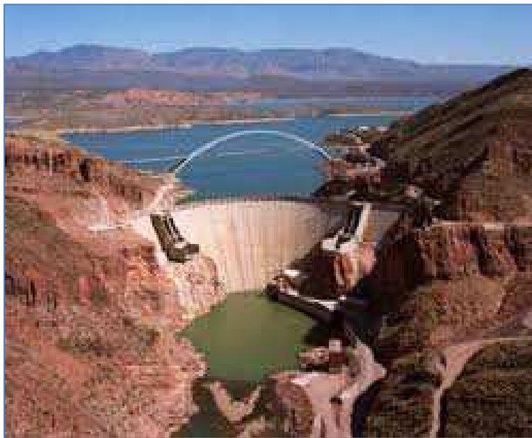
Figura 2-6 Barragem em arco (Safety, 2013).
