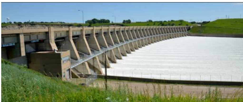
Figura 2-7- Barragem reticulada (FEMA, 2013).
