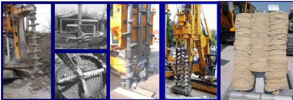
Figura 2-43 Equipamentos utilizados no sistema DMM (Bruce,1998).
