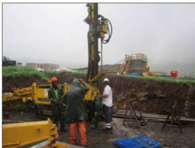
Figura 3-22 Aspecto Geral do Equipamento de perfuração (MEECFG, 2012).
