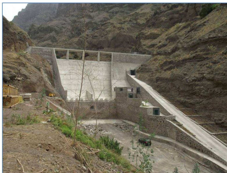
Figura 2-4 - Barragem de alvenaria de pedra.
