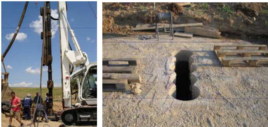
Figura 2-42 Imagens de construção de Estacas Drenantes (Bruce,1998).
