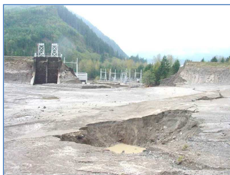
Figura 2-33 - Localização do ponto de escoamento na albufeira Canal Swift2 em Washington (Schaefer, 2009).
