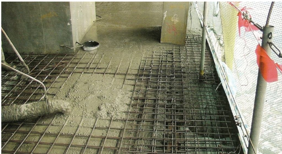
Figura 7.5 – Betão com consistência fluida (García, 2006)
