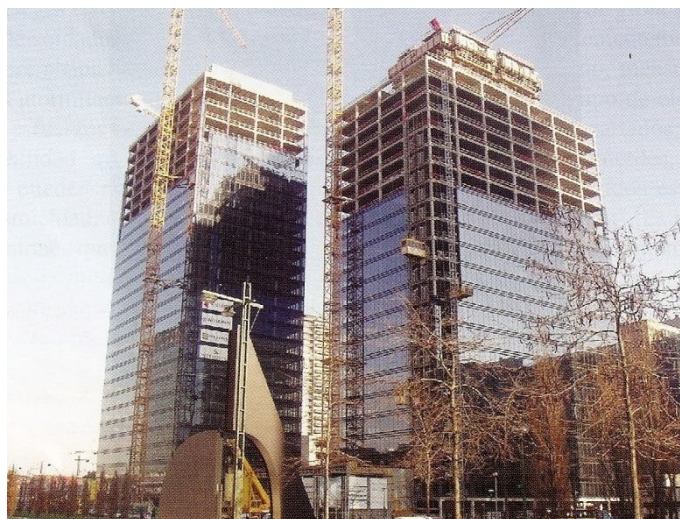
Figura 8.2 – Edifícios North Galaxy (Bruxelas) (Cruz, 2009)
