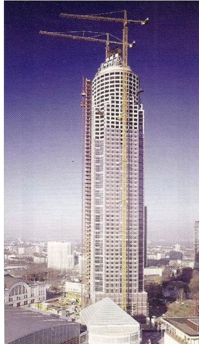
Figura 9.7 – Gruas ligadas a edifício (Manitowoc, 2010)
