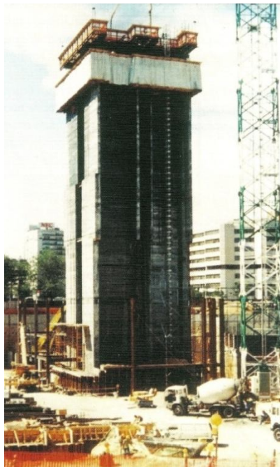
Figura 5.32 – Núcleo deslizado no edifício Puerta de Europa (Madrid) (Somavilla, 2005)
