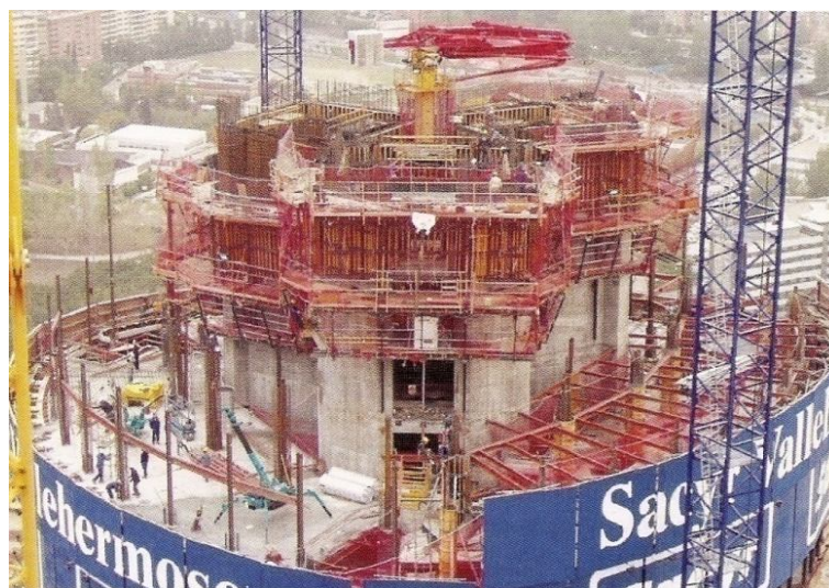
Figura 11.7 – Avanço da estrutura da Torre Sacyr-Vallehermoso (Calzón; Navarro, 2008)
