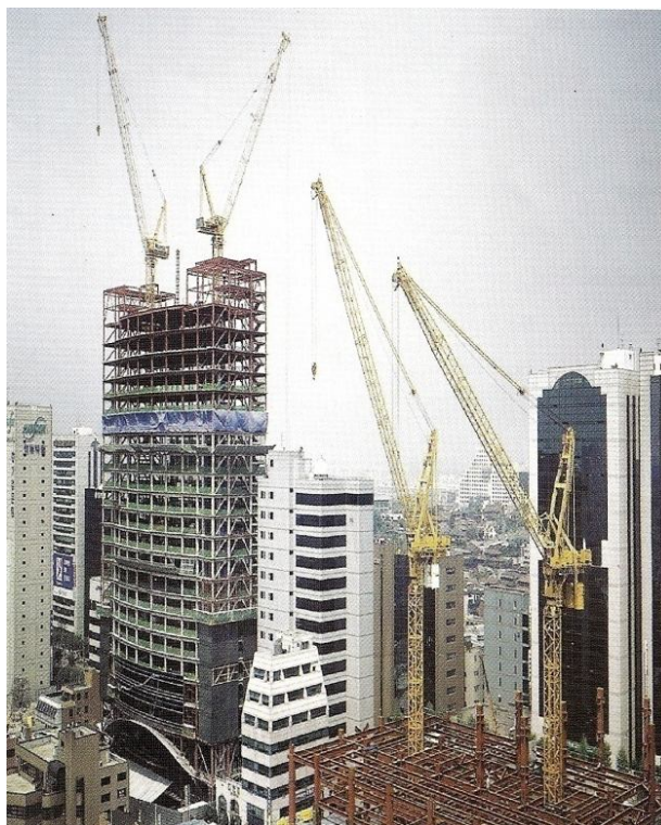
Figura 9.21 – Gruas trepantes dentro de um edifício (Liebherr, 2010)
