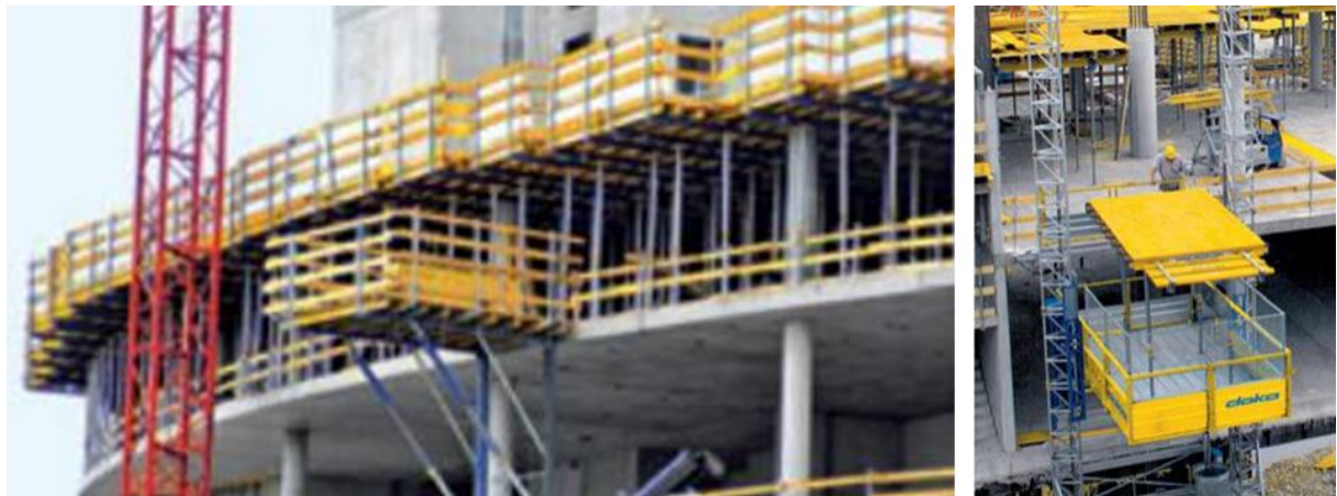
Figura 4.11 – Plataforma extensível de elevação e sistema de elevação suspenso da laje de mesas móveis (Doka, 2007)
