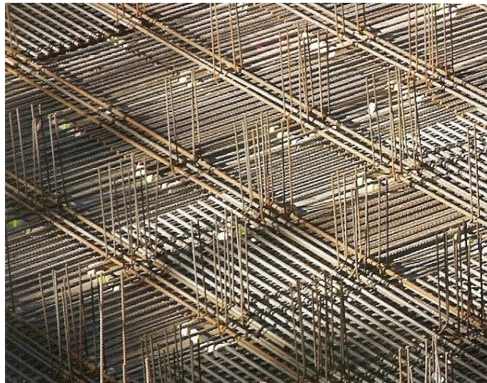
Figura 6.2 – Industrialização das armaduras em laje de fundação (Gallego, 2006)
