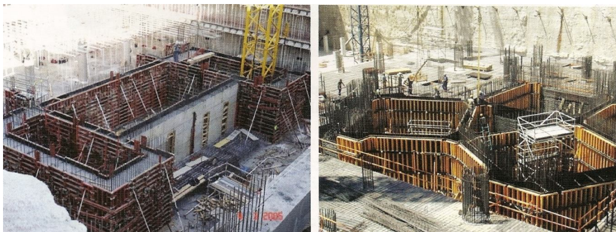
Figura 5.1 – Arranques de núcleos com cofragem tradicional (Somavilla, 2005)
