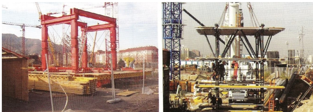
Figura 5.25 – Pré-montagens de plataformas interiores (Somavilla, 2005)
