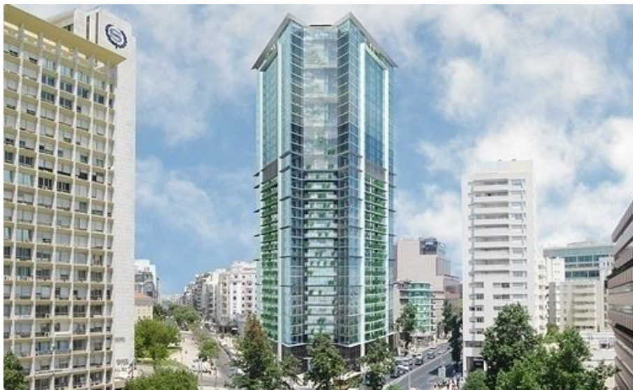
Figura 12.6 – Edifício Compave ( http://www.skyscrapercity.com/ )
