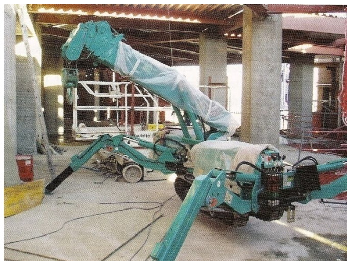
Figura 11.3 – Mini-grua para montagem de estrutura metálica (Urzaiz, 2006)
