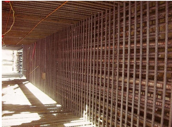
Figura 6.3 – Bainhas de pré-esforço em muro de núcleo na Torre Espacio (Navarro; Calzón, 2008)
