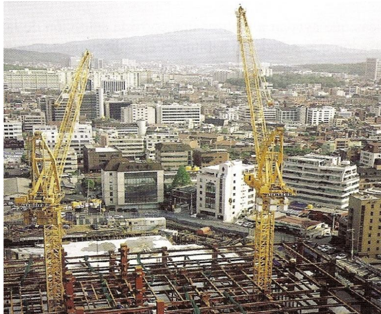
Figura 9.2 – Guas de lança abatível (Liebherr, 2010)
