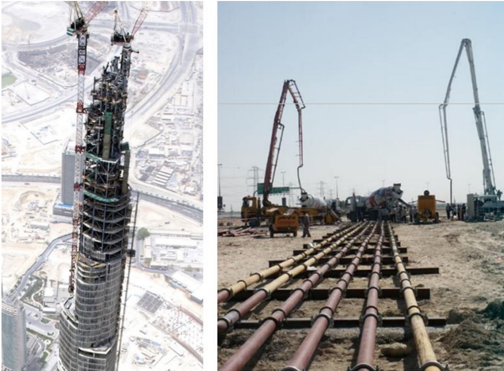
Figura 7.1 – Burj Khalifa. Aspecto do sistema de bombagem de betão (Cruz, 2009)
