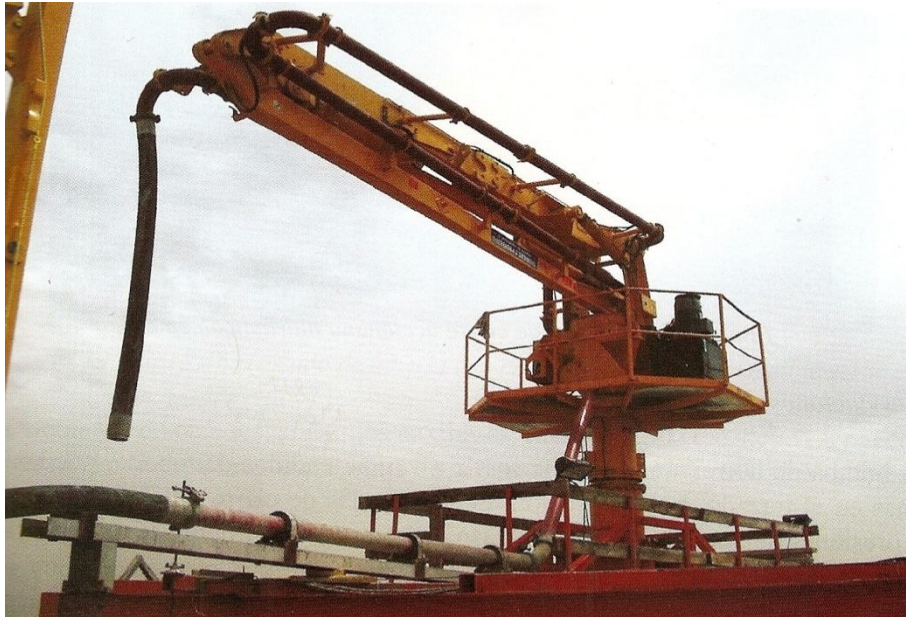
Figura 7.14 – Mangueiras de distribuição intermédias e finais (Urzaiz, 2006)
