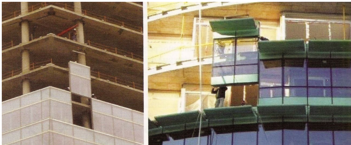
Figura 11.5 – Montagem de fachadas cortina a partir de pisos superiores (Eisele; Kloft, 1999)
