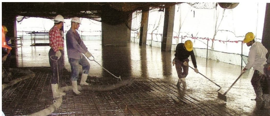
Figura 7.24 – Distribuição de betão com mangueira final (García, 2006)
