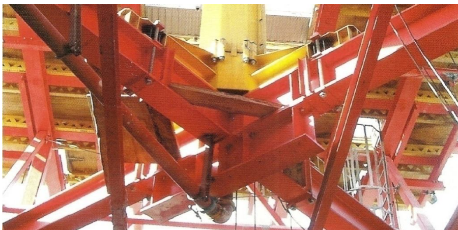
Figura 7.22 – Lança de distribuição montada sobre cofragem auto-trepante (Ferrer, 2006)
