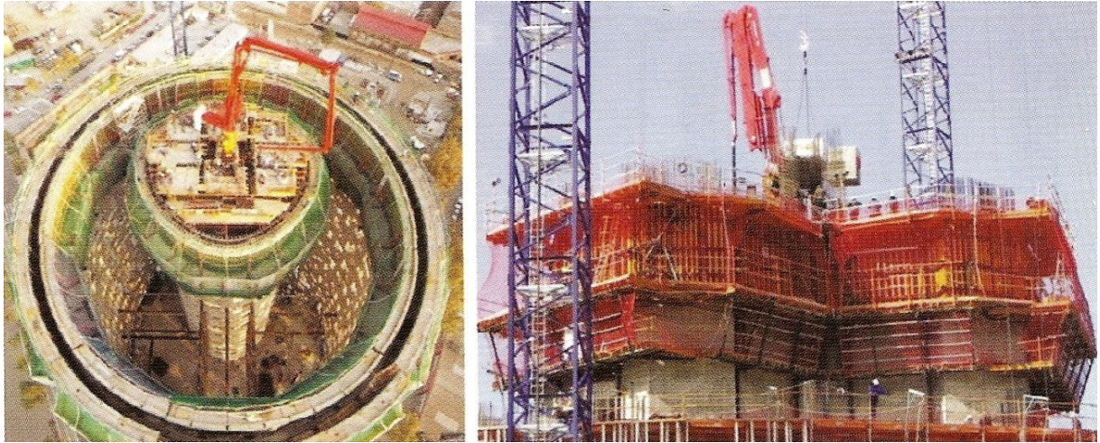
Figura 5.20 – Distribuidor de betão sobre plataforma interior na Torre Agbar (Barcelona) e Torre Sacyr-Vallehermoso (Hermoso, 2005)
