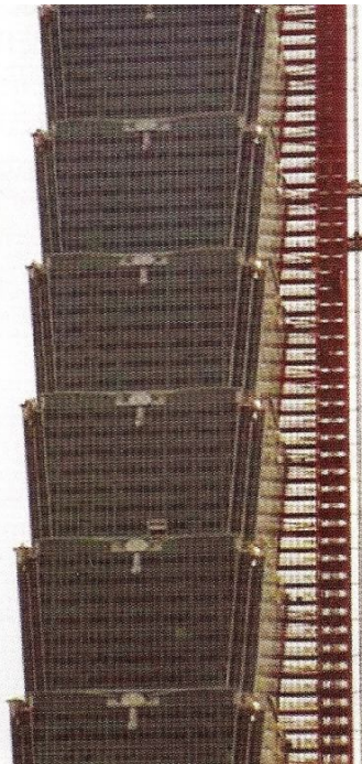
Figura 11.2 – Plataformas de acesso entre o monta-cargas e os pisos no edifício Taipei 101 (Cruz, 2009)
