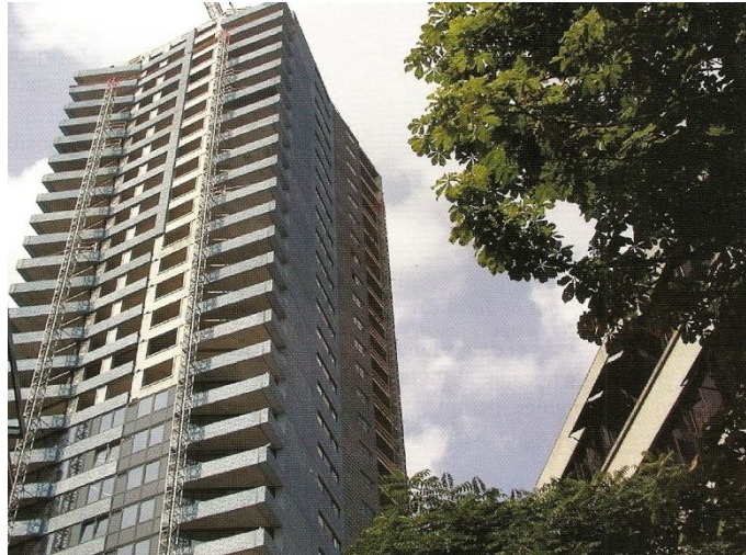
Figura 8.5 – Edifício construído integralmente com painéis portantes (Holanda) (Cruz, 2009)
