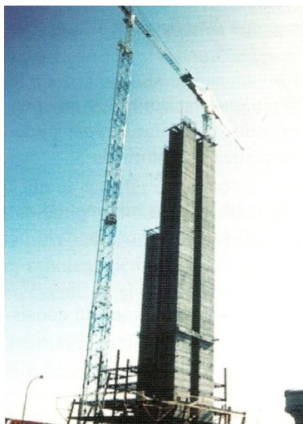
Figura 5.38 – Grua auto-estável (150m) para deslize de núcleos (Somavilla, 2005)
