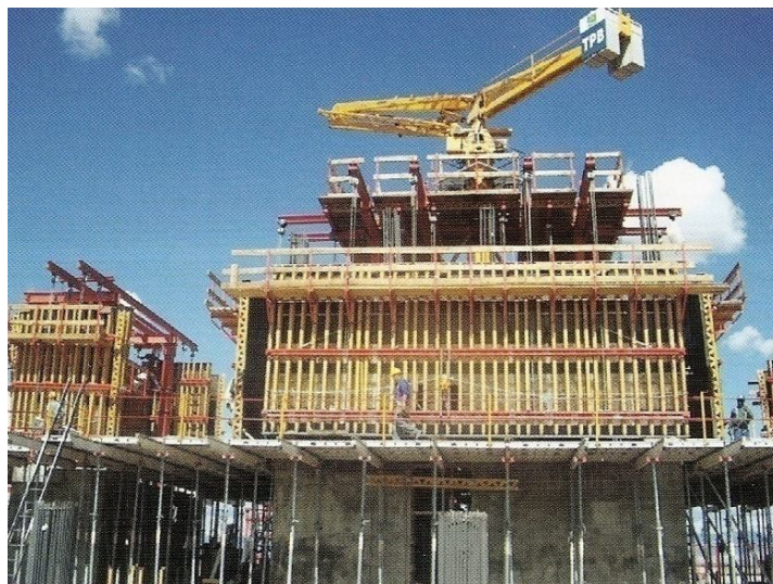
Figura 5.24 – Betonagem monolítica na Torre Espacio. Plataformas interiores em núcleos com cofragem exterior suspensa (García, 2006)
