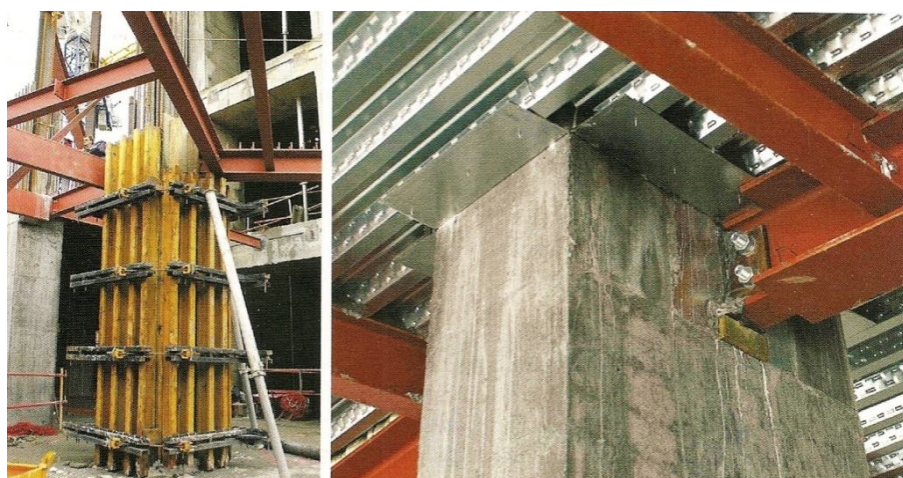
Figura 3.14 – Cofragem modular de contraplacado com película fenólica e remate de capitel (Sainz, 2006)
