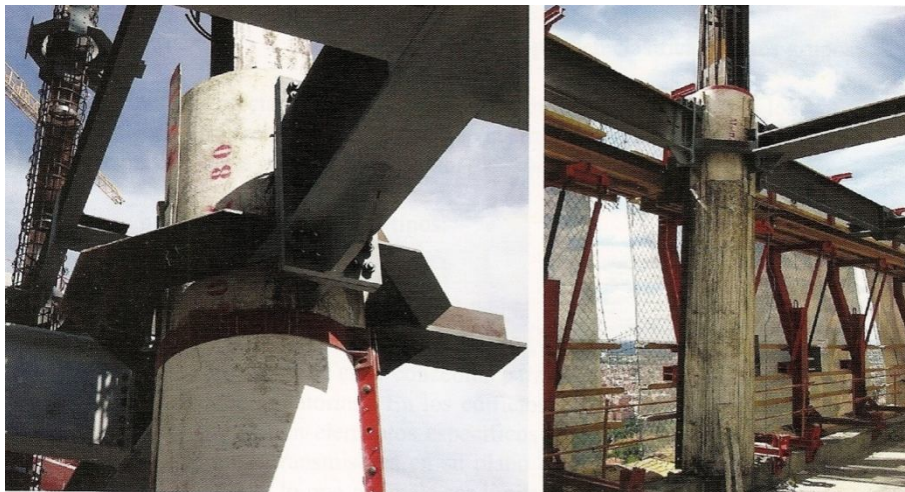
Figura 3.16 – Cofragem sintética e remate de capitel (Ferrer, 2006)
