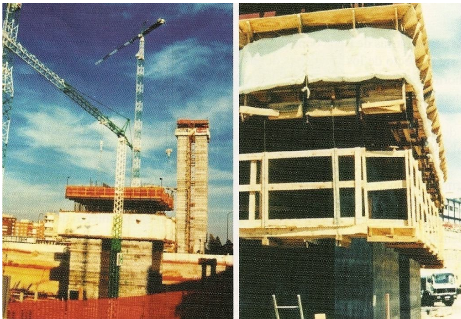
Figura 5.36 – Plataformas em cofragens deslizantes (Somavilla, 2005)
