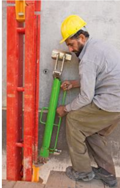
Figura 5.31 – Incorporação de sistemas hidráulicos numa cofragem trepante guiada (Peri, 2008)
