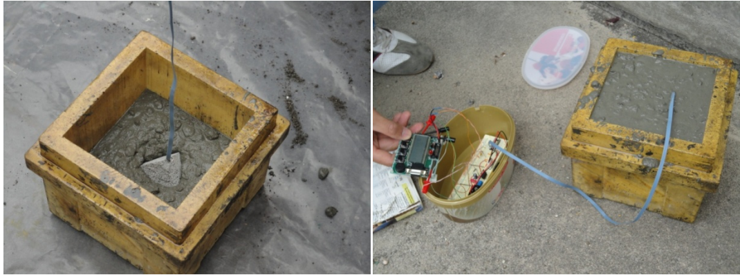
Figura 30 - Colocação do sensor dentro do betão (esquerda), arranque do sistema após betonagem (direita) [F18].
