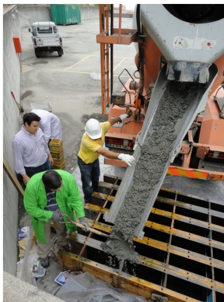
Figura 29 - Inicio da betonagem [F18].
