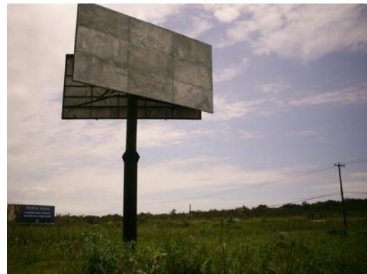
Figura 4 – Estrutura de publicidade
