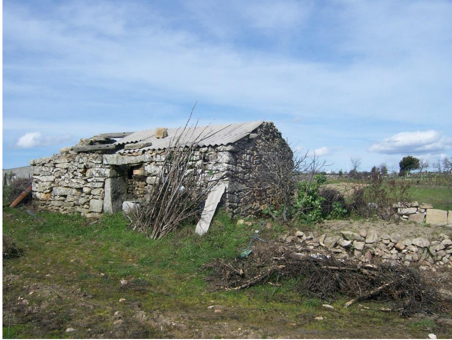
Figura 31 - Edifício rústico existente (D)
