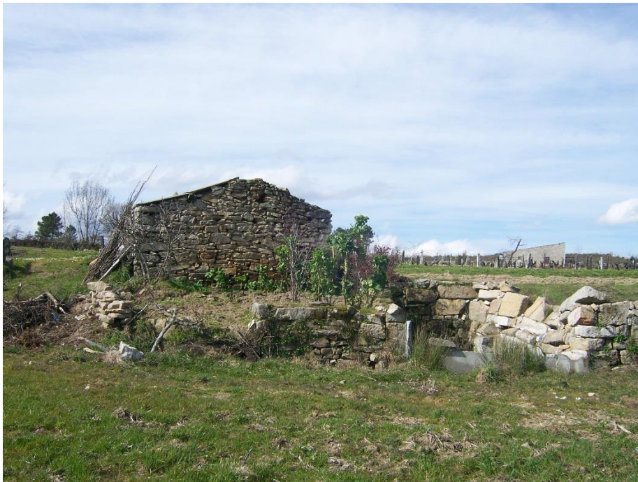
Figura 30 – Edifício rústico existente (C)
